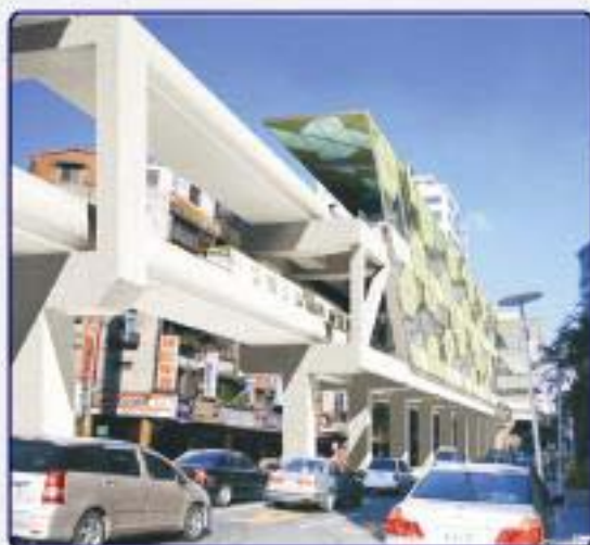
中和區中山路二段車站區疊式鋼結構箱型梁高架橋電腦模擬圖
