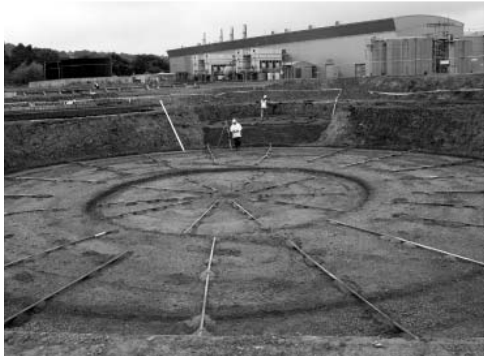
Zählen auf gute Nachbarschaft und kurze Wege: die Betreiber der im Hintergrund zu sehenden Lebensmittel- und Fleischfabrik und die der neu entstehenden Biogasanlage in Wales.
