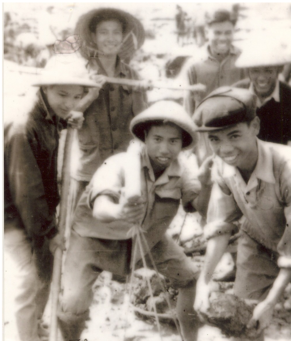
Sinh viên khóa 1, ngành Xây dựng Dân dụng & Công nghiệp lao động tại công trường thủy nông Bắc Hưng Hải (1958)
