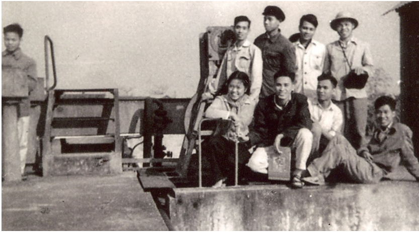
Sinh viên ngành Thủy lợi, khóa 1, khoa Xây dựng thực tập tại Đập Đáy, năm 1959
