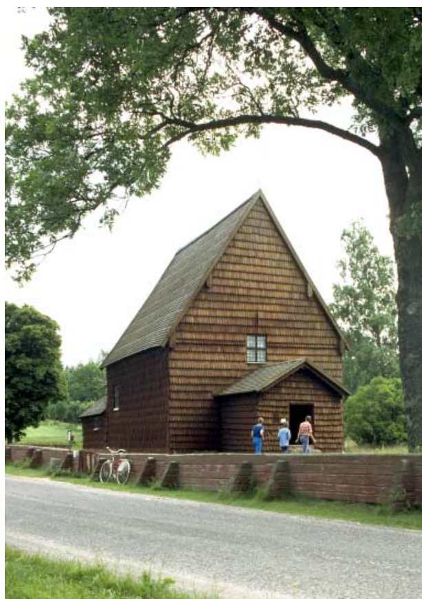
Södra Råda gamla kyrka vid mitten av 1980-talet, sedd från väster. Foto: Pål-Nils Nilsson, ATA.
