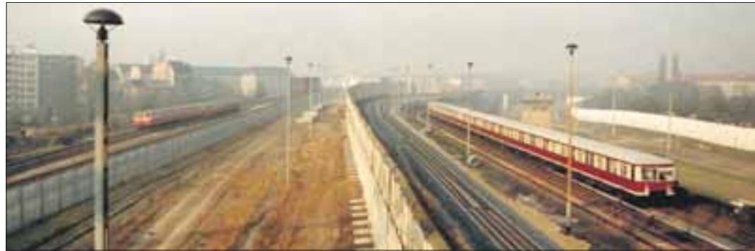
Die Mauer zerteilte das einstmals miteinander verknüpfte Gleisgefüge von 1961 an
