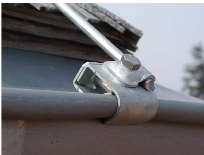
Рис. 29. Пример выполнения соединений металлического водосточного желоба с элементами молниезащитного устройства.
