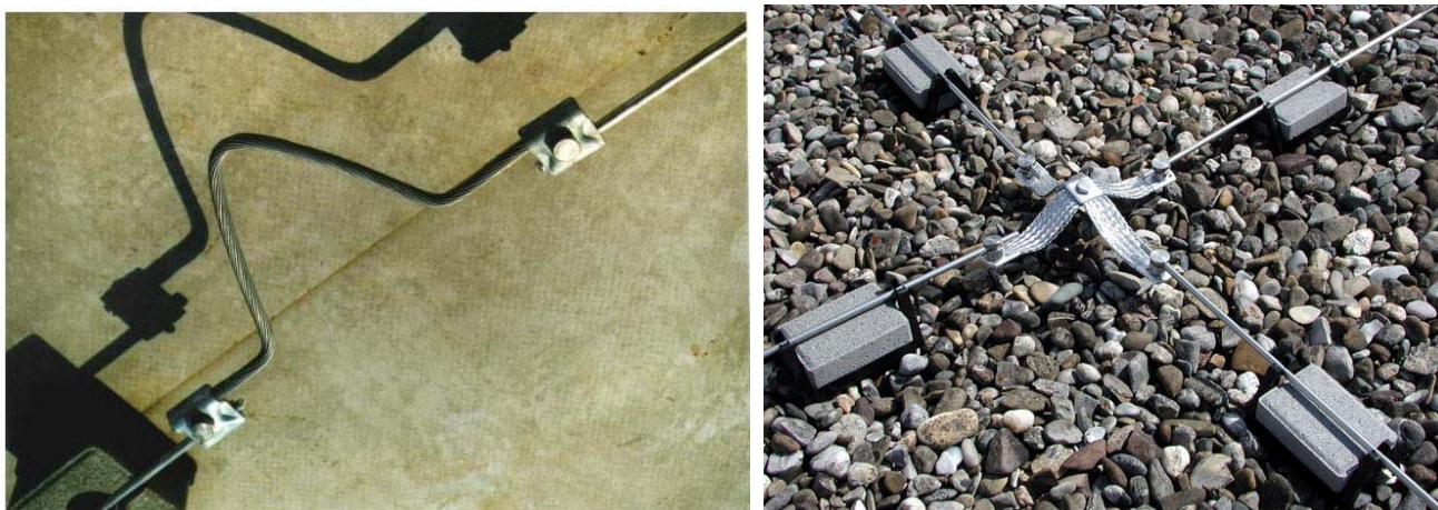
Рис. 6. Соединения, компенсирующие напряжения, возникающие при изменении температуры
