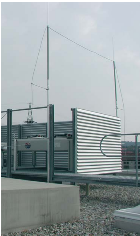
Рис. 16. Примеры молниеприемников, прикрепленных к защищаемым объектам []
