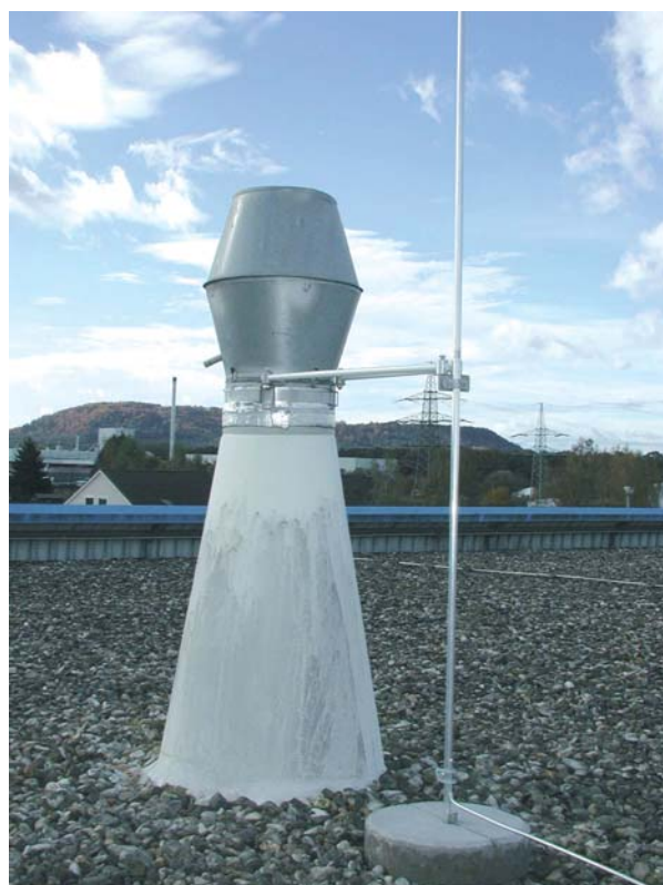
Рис. 16. Примеры молниеприемников, прикрепленных к защищаемым объектам []
