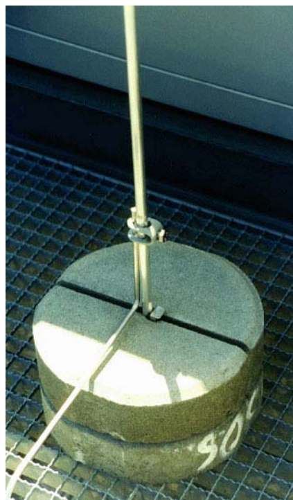
Рис. 11. Крепление молниеприемников различной высоты к бетонным опорам
