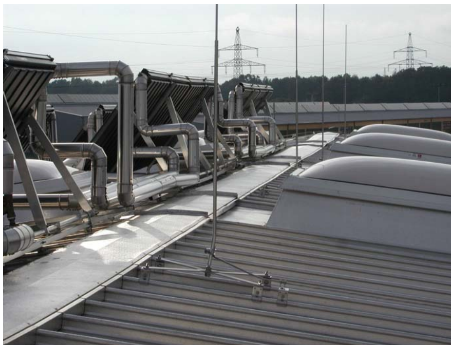
Рис. 12. Крепление приемников к проводящим элементам поверхности крыши
