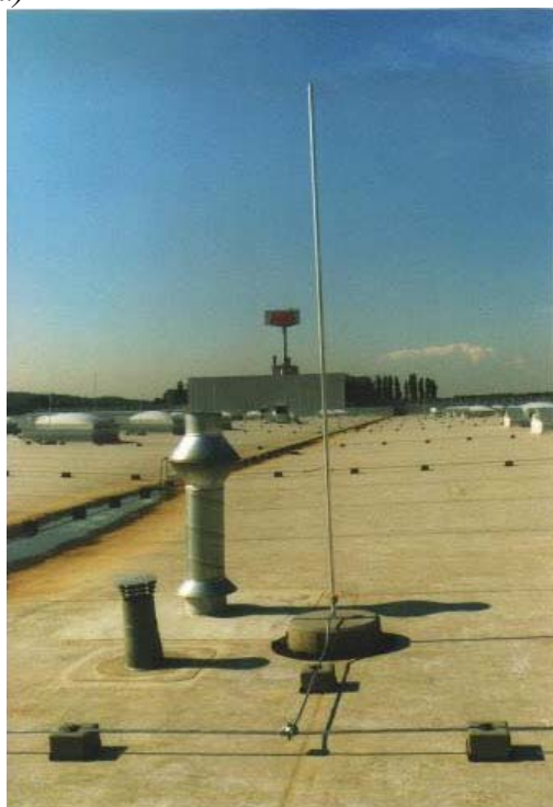
Рис. 8. Молниеприемники на крыше строительного объекта ; а) одиночный молниеприемник, б) определение защитной зоны, созданной системой двух молниеприемников
