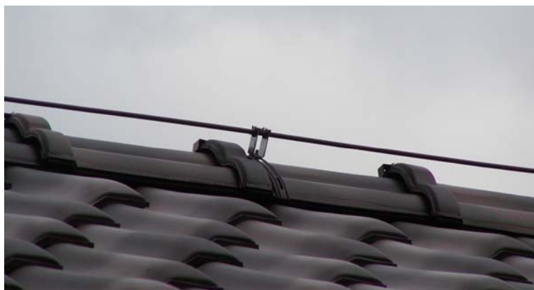
Рис. 28. Молниеприемники на двухскатных крышах. Размещение кронштейнов и примеры монтажа
