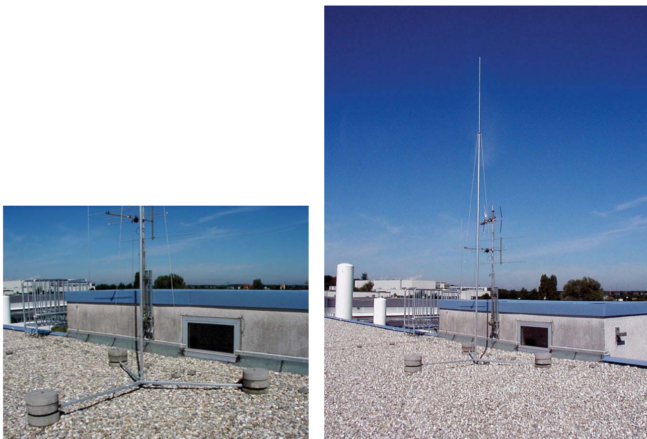
Рис.14. Одиночные вертикальные молниеприемники [ ]
