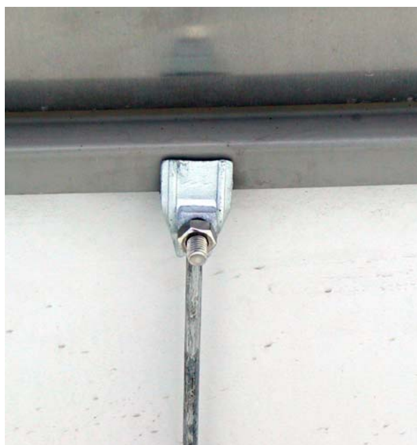
Рис. 31. Отведение тока молнии с металлического покрытия крыши
