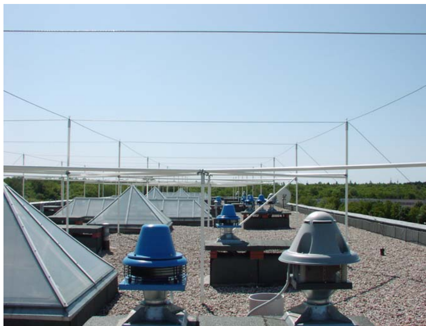
Рис. 27. Молниезащита устройств на крыше строительного объекта
