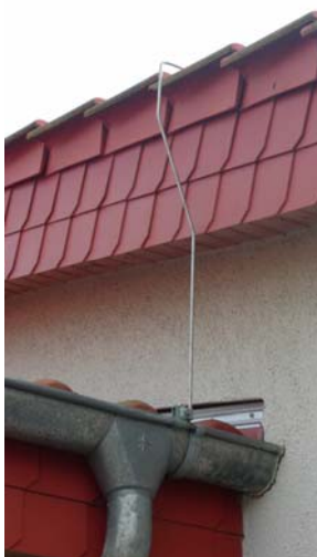
Рис. 29. Пример выполнения соединений металлического водосточного желоба с элементами молниезащитного устройства.
