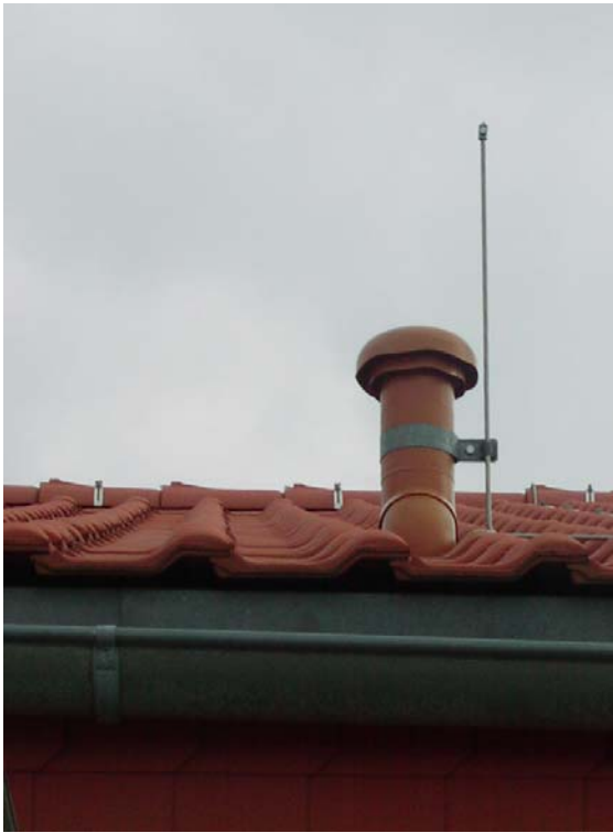
Рис. 30. Примеры исполнения молниезащиты труб на крышах, крытых черепицей
