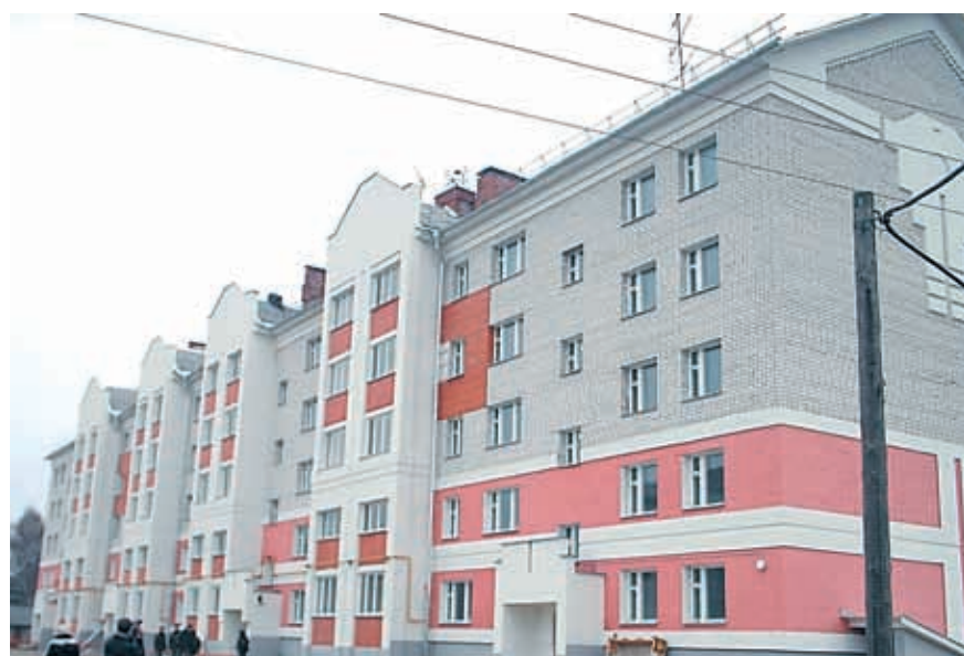
67-КВАРТИРНЫЙ ЖИЛОЙ ДОМ ГОТОВ К ПРИЕМУ НОВОСЕЛОВ.
