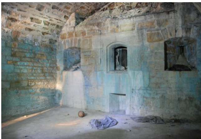
Ouverture pour canon à mitraille (au milieu) meurtrières à fusiliers (de chaque côté)
