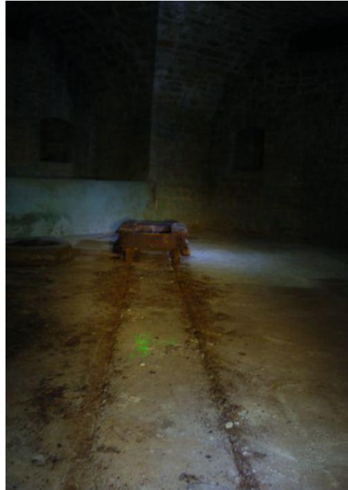
Rails de circulation pour wagonnets
