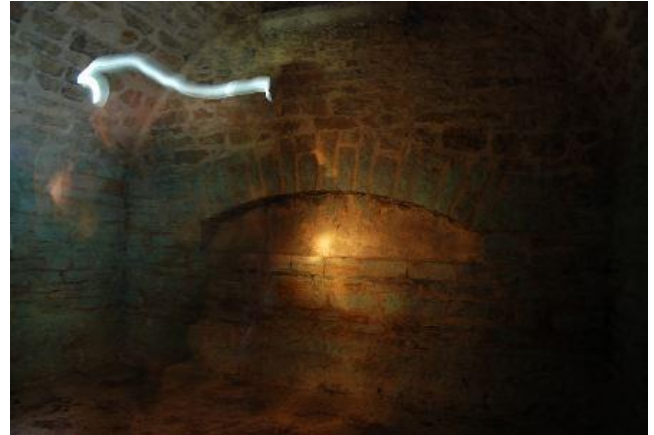
Embrasure pour canon (façade sur ancien fossé)
