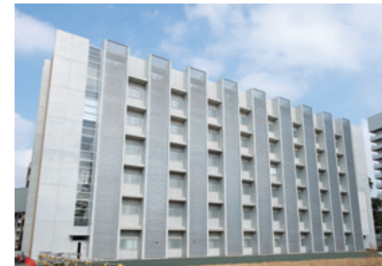
3号館(北棟)2010年11月竣工
