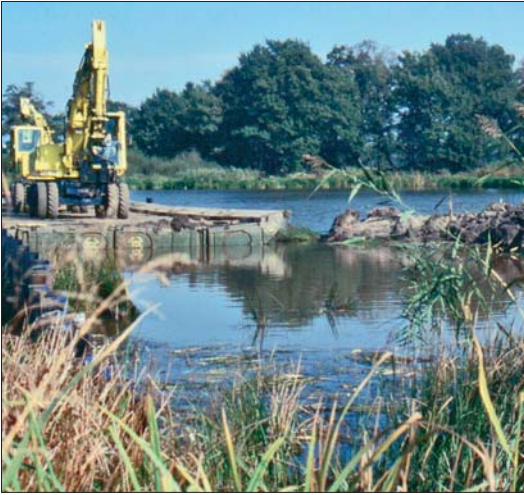
Abb. 2: Baggerarbeiten zur Sanierung des Kühnauer Sees. Foto: Archiv BR.
