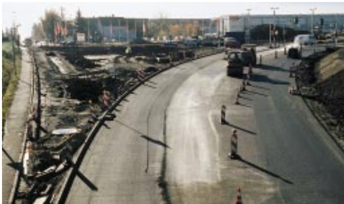
Am linken Bildrand erkennbar: der ehemalige Straßenverlauf nach Bernhausen
