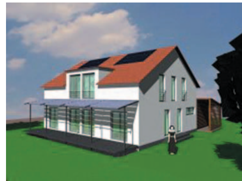
Slika 5. Obiteljska kuća - AUGGEN (D) Ukupne toplinske potrebe: 14,5 kWh/m 2 godišnje
