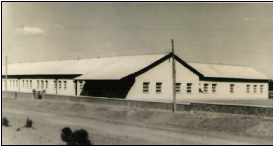
Edificio de la Escuela N° 122 cuando estaban por inaugurarlo. Año 1949.
