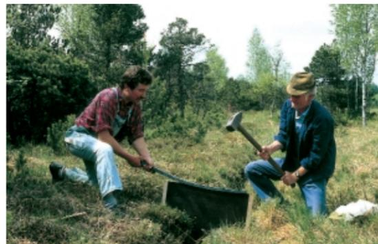
Kleinere Entwässerungsgräben lassen sich wirkungsvoll durch das Einschlagen einer mehrfach verleimten Sperrholzplatte aufstauen. Breitere Gräben müssen durch einen Damm abgedichtet werden.
