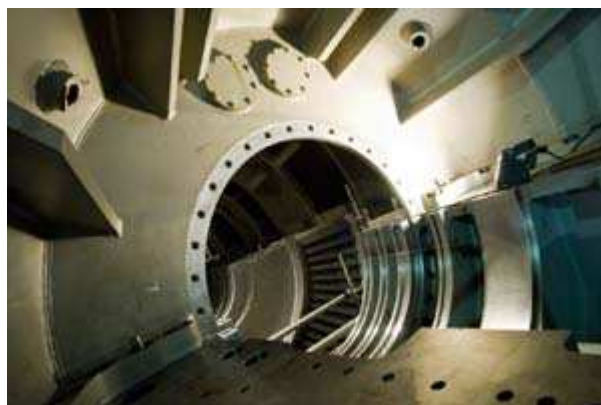
Travaux de mesure sur machine Turbine à Vapeur en cours de montage Février 2010 / PATRICK MARTIN PHOTOGRAPHE
