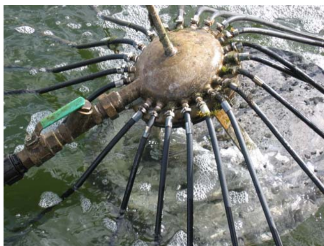
Figur 8.6 Ilttank og fordampere på Stavnsholt Renseanlæg samt manifold med diffusor-slanger.
