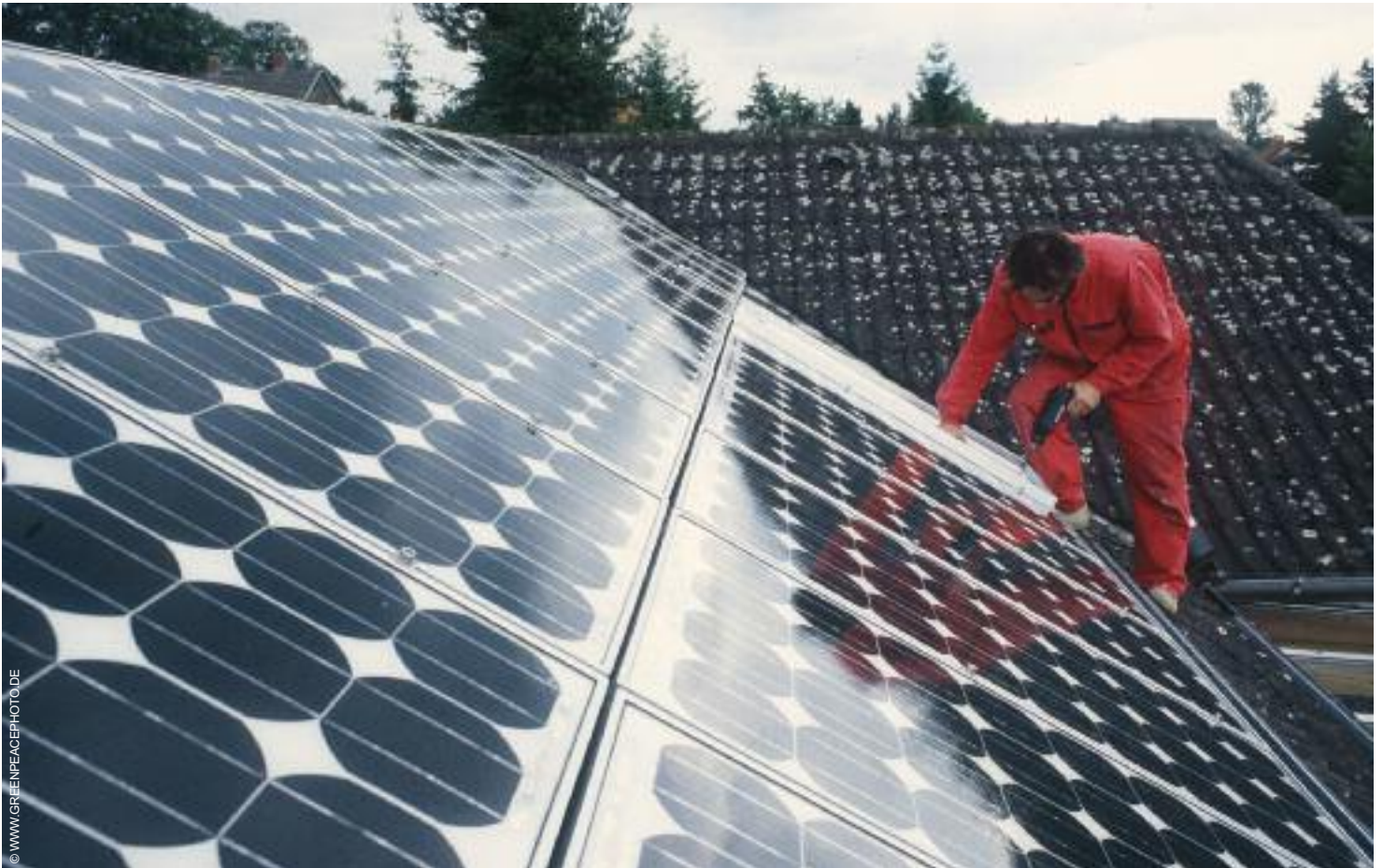
kép NAPELEMEK FELSZERELÉSE EGY LAKÓHÁZRA.
