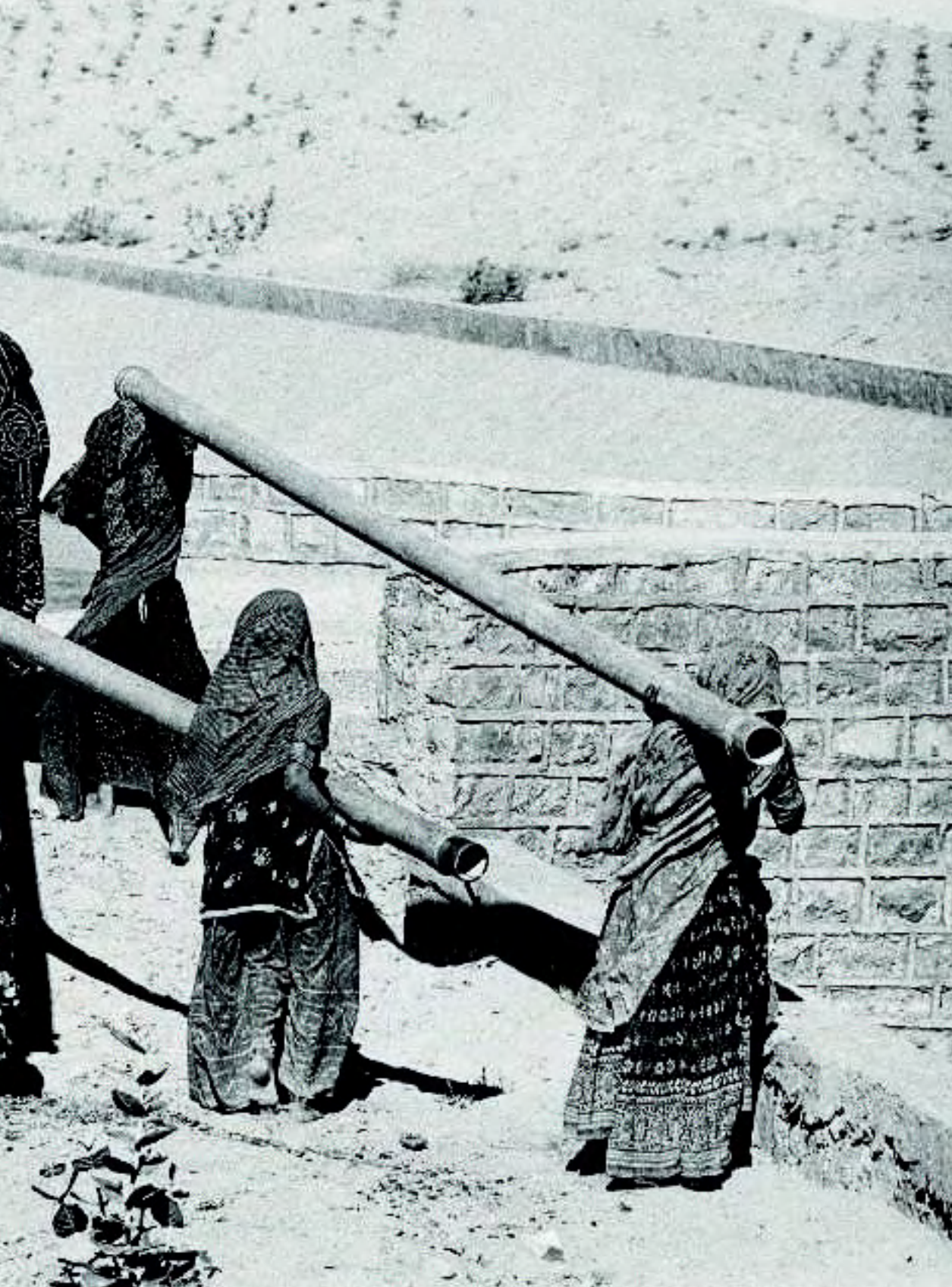
SALGADO 1989, CHANTIER DU CANAL DU RAJASTHAN, INDE Transport de tuyaux destinés à l'irrigation. Tirage argentique, format 40/50 cm
