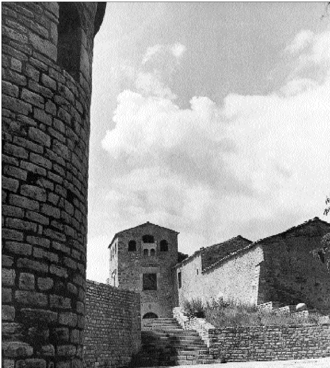
Fachada de la casa del prior de Roda de Isábena
