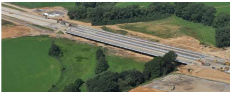
Most přes Dobřejevický potok
