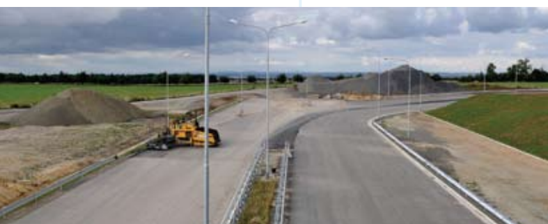
MÚK Satalice před dokončením, pohled směr Vinoř
