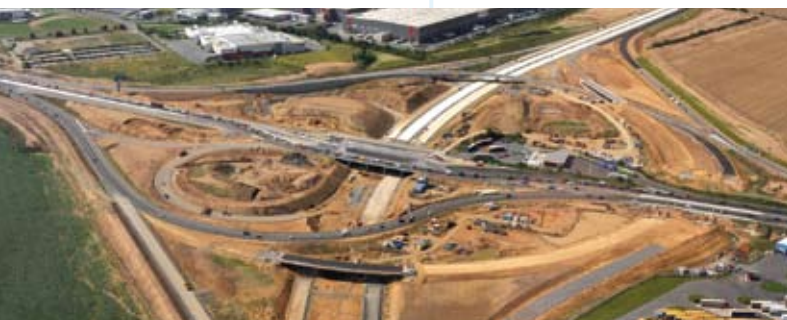
MÚK Modletice – stavba křižovatky Pražského okruhu a dálnice D1
