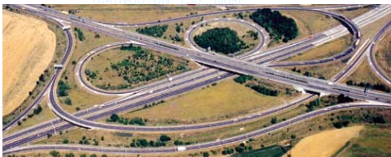
MÚK Třebonice - křižovatka Pražského okruhu a dálnice D5
