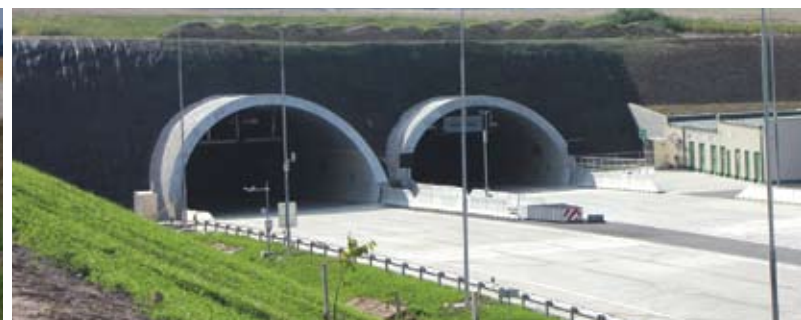
Východní portály tunelu Cholutice
