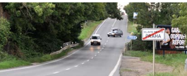
Údolí Ctěnisckého potoka, budoucí MÚK Vinoř
