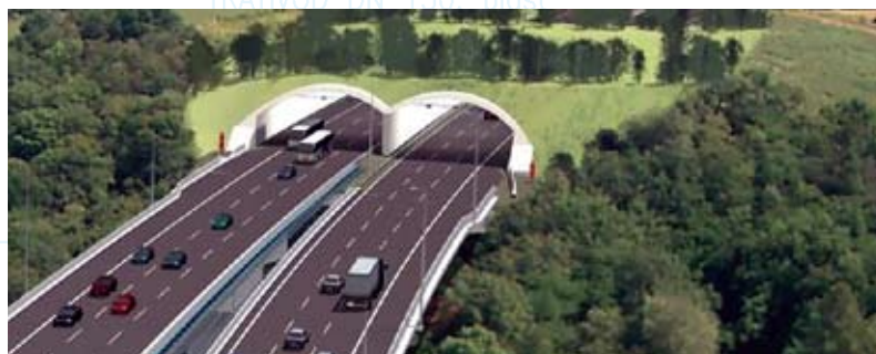
Most přes údolí Čimického potoka a ekodukt
