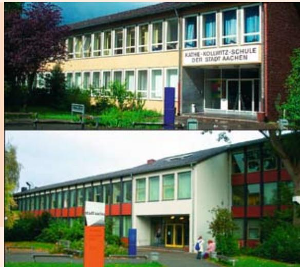
Die Käthe-Kollwitz-Schule in Aachen – ein EnSan-Projekt – vor (im Bild oben) und nach der Sanierung: Das Gebäude aus den 50er Jahren, heute genutzt als Berufskolleg, verbraucht 65 Prozent weniger Energie für Heizung und Warmwasser sowie 15 Prozent weniger Strom als zuvor.
