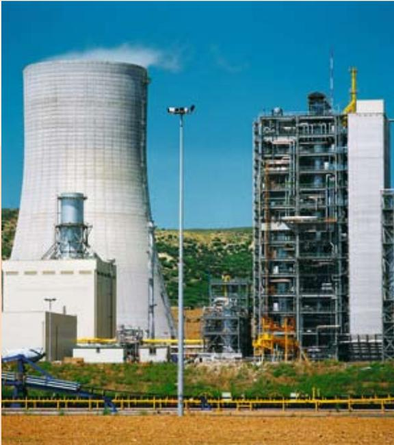
Beim Integrated Gasification Combined Cycle (IGCC) wird Kohle in ein Brenngas umgewandelt, das die Dampfturbine eines GuD-Kraftwerkes antreiben kann.
