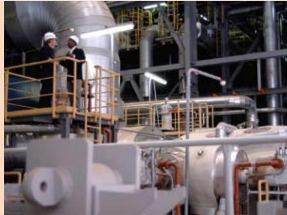
Dampfturbine im GuD-Kraftwerk Mainz-Wiesbaden. Mit einem Wirkungsgrad von 58 Prozent ist es eines der effizientesten der Welt.
