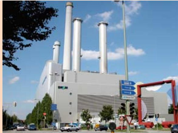
Gut 160 Gigawattstunden mehr Strom pro Jahr erzeugt die neue GuD-Anlage im Münchener Süden, indem sie die Turbinenabwärme nicht in ein Dampf-Fernwärmenetz, sondern in das neue Heißwassernetz auskoppelt (Bild links).
