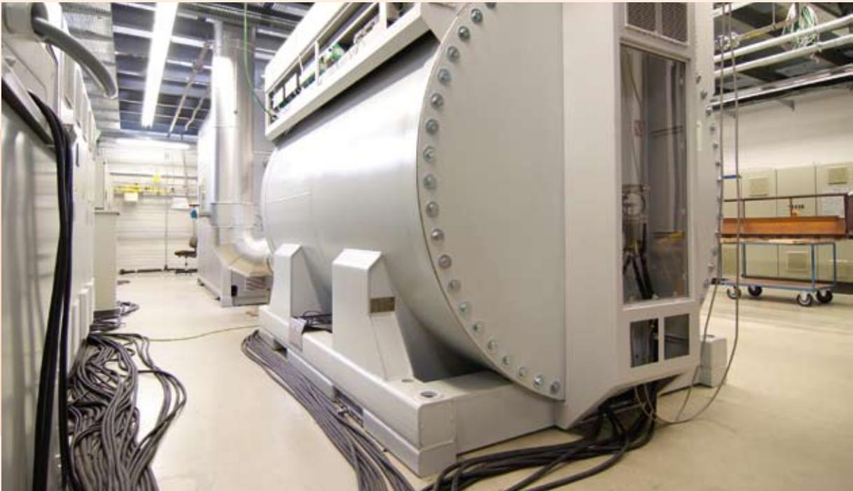
Beim „Hot Module“ ist es den Konstrukteuren gelungen, alle heißen Teile in ein gemeinsames Gehäuse zu integrieren. Dadurch werden nicht nur Teile der Peripherie überflüssig, auch der Wirkungsgrad setzt neue Maßstäbe. Ohne Flamme und ohne bewegte Massen wie rotierende Turbinenschaufeln oder eine Kolbenbewegung setzt das Hot Module die Energie des Gases direkt in Strom und Wärme um.
