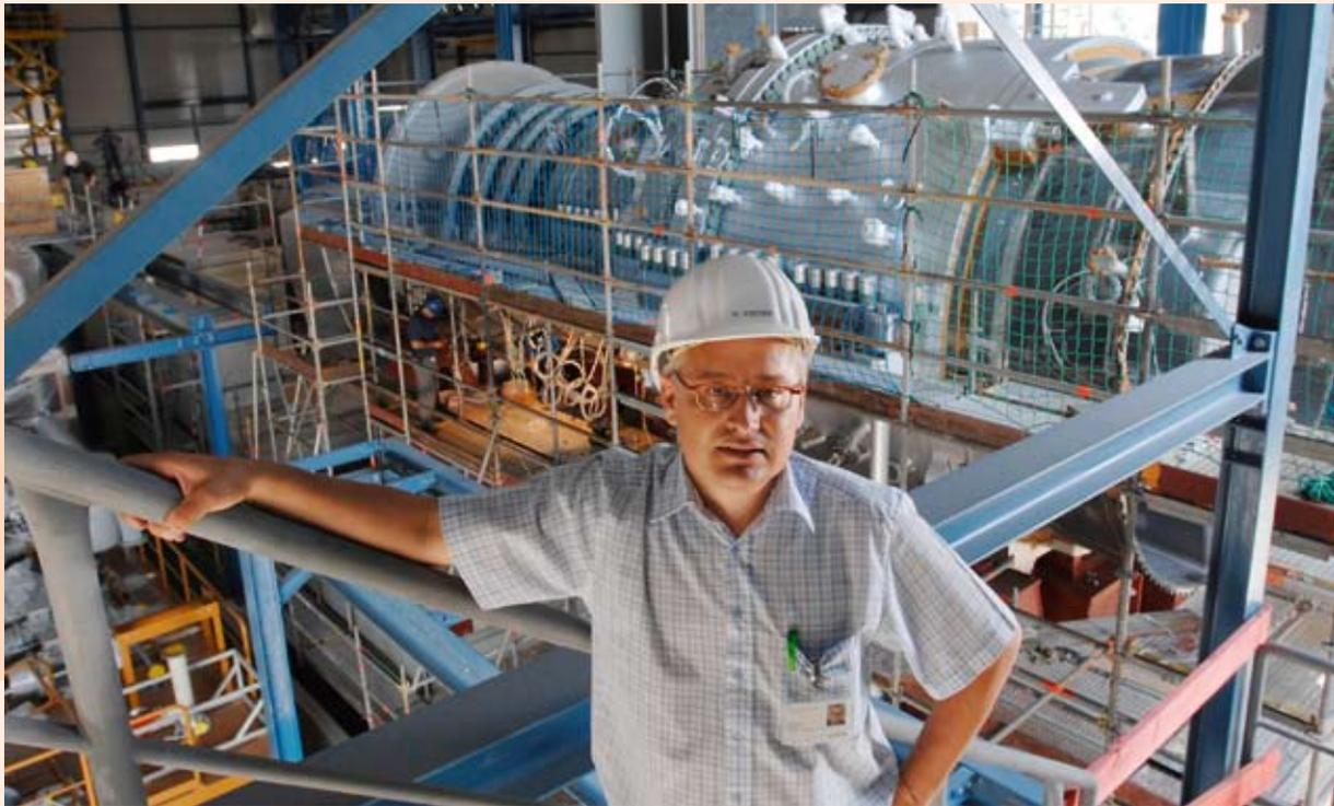
Die SGT5-8000H leistet im Kraftwerk Irsching 340 Megawatt. Nach der Testphase wird diese Anlage zu einem hocheffizienten GuD-Kraftwerk mit einer Leistung von rund 530 Megawatt und einem Wirkungsgrad von über 60 Prozent erweitert.
