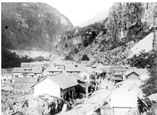
Il villaggio operaio di Balmalonesca (archivio Collegio Rosmini Domodossola)
