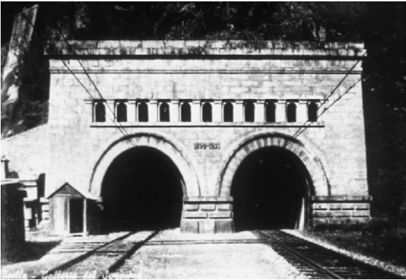
Ingresso del traforo del Sempione a Iselle (archivio Collegio Mellerio Rosmini)
