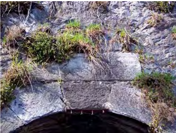
L'iscrizione Rep. Ital. MDCCCIII posta presso il ponte a conclusione del lavoro
