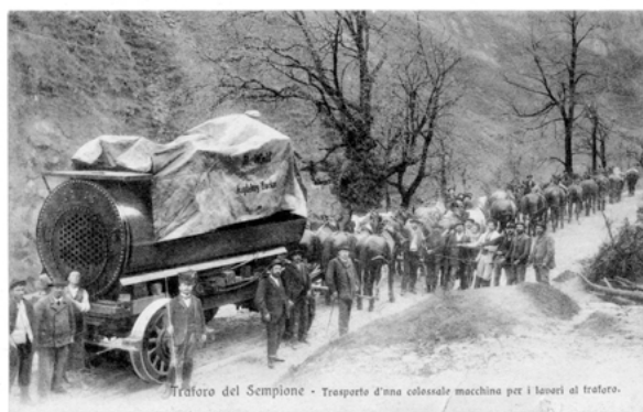
Il trasporto da Domodossola di una pesantissima caldaia a vapore per i lavori al traforo (archivio Collegio Mellerio Rosmini)
