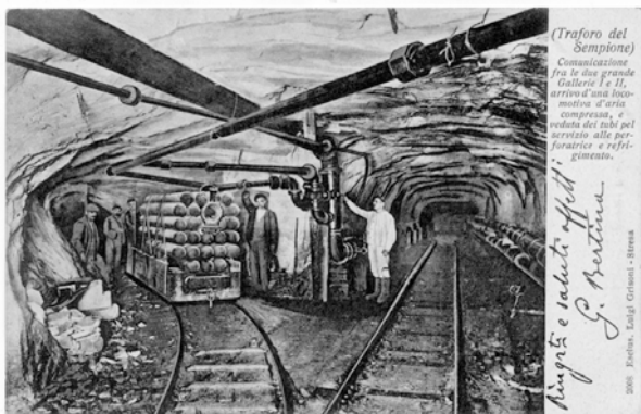
Operai al lavoro nel tunnel: si osservano le due gallerie affiancate
