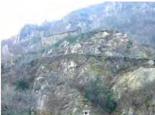
Tratto della strada romana con opere di sostegno a Vogogna
