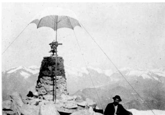
Postazione per le triangolazioni trigonometriche per definire il tracciato del tunnel in una foto d'epoca (archivio Collegio Rosmini)
