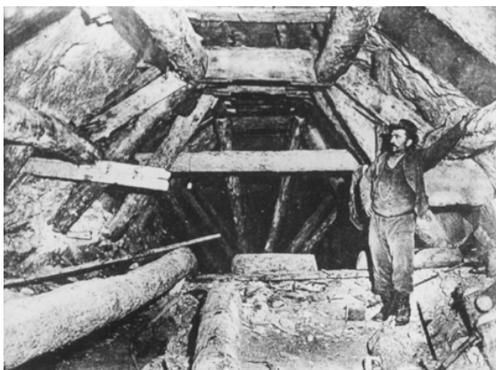
Il complesso sistema di sostegno delle volte del tunnel con travi in legno (archivio Collegio Mellerio Rosmini)
