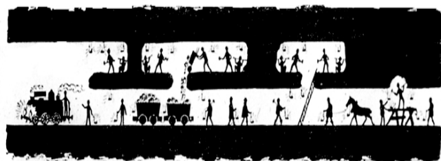
Schema illustrativo del modo di procedere nello scavo del tunnel (archivio Collegio Mellerio Rosmini)
