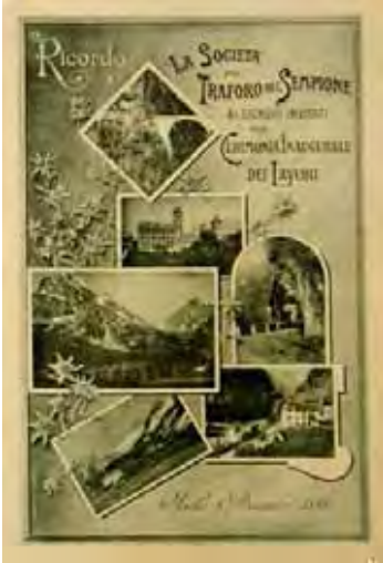
Cartoncino di inaugurazione dei lavori al Sempione (archivio Musei Civici Domodossola)
