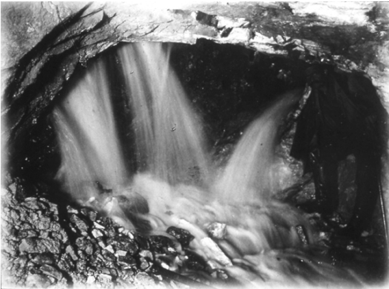
Irruzione di acque da sorgenti sotterranee nella galleria del traforo (archivio Collegio Mellerio Rosmini)
