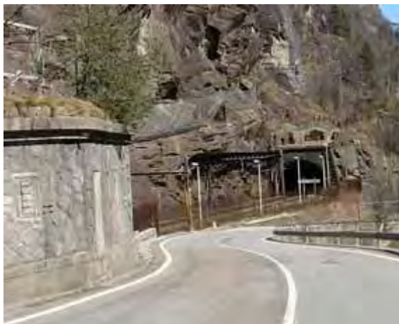
Opere difensive lungo la strada e sopra l'ingresso di una galleria ad Iselle
