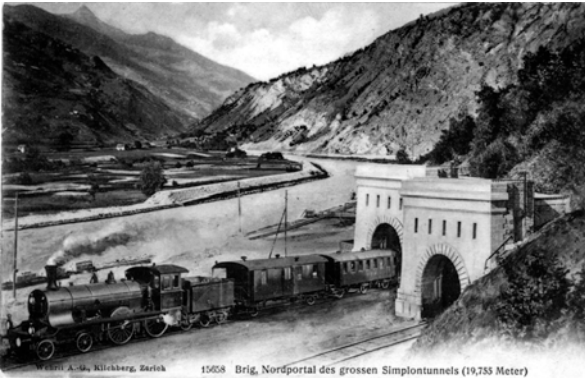
Ingresso del traforo del Sempione a Briga (archivio Collegio Mellerio Rosmini)
