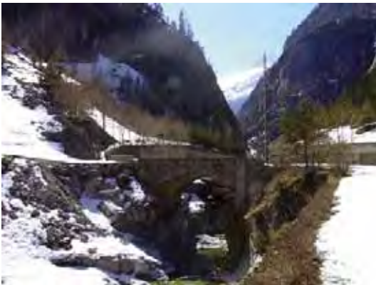
Ponte presso le gallerie di Gondo oggi
