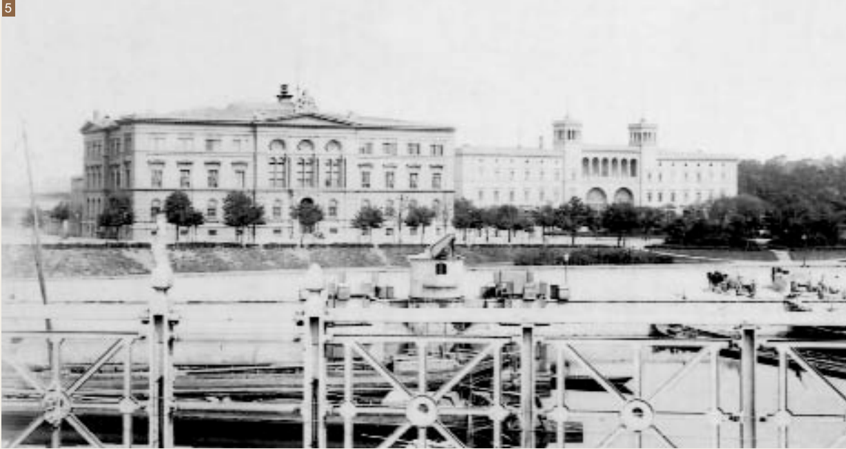
5 Blick über den Humboldthafen um 1883: Der Hamburger Bahnhof mit dem Ver- waltungsgebäude der Berlin-Hamburger Eisenbahngesellschaft
