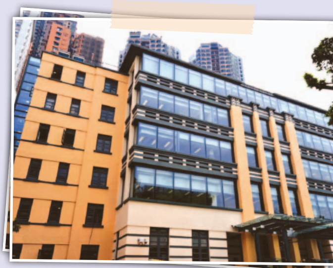
▲ 高街舊半山區警署已翻新及改建，並加建一座新翼大樓以重置戴麟趾康復中心
