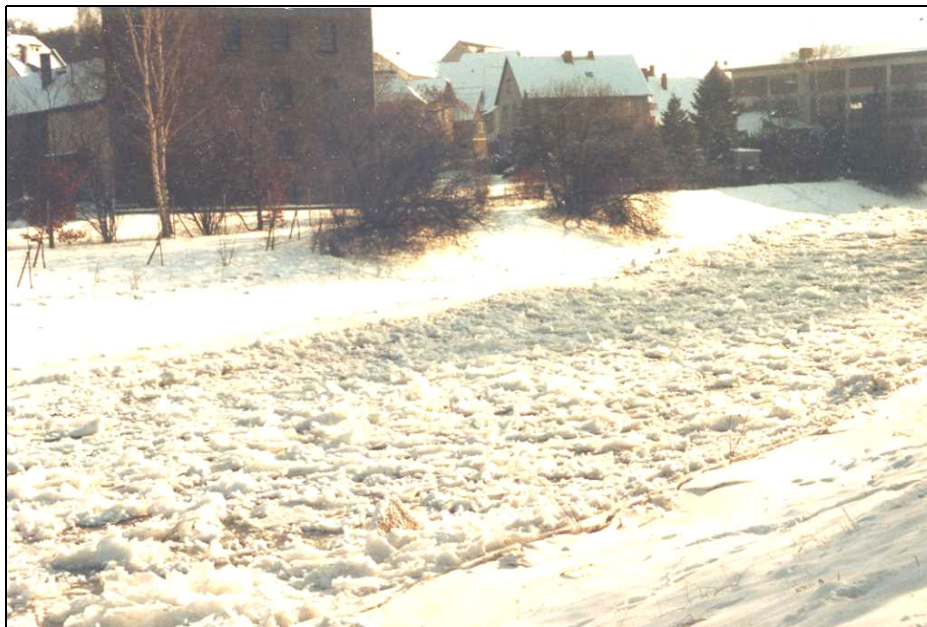
(Foto: G. Lehr ) Vereisung der Nidda im Winter 1983/84 Die Vereisung bewirkte ein Abrutschen der Ufer und das Aufbrechen der Steinbefestigung. Hierdurch entstanden „ Minibiotope“
