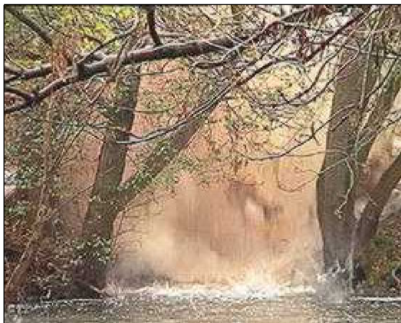
(Foto: G.R. Pelz ) Sprengung des Erlenbachwehres, November 2001
