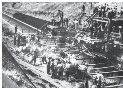
Construcción del canal por presos condenados a trabajos forzados
