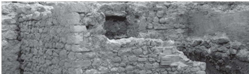
Torre de la muralla. Foto: Cinta Cantarell. 2005
