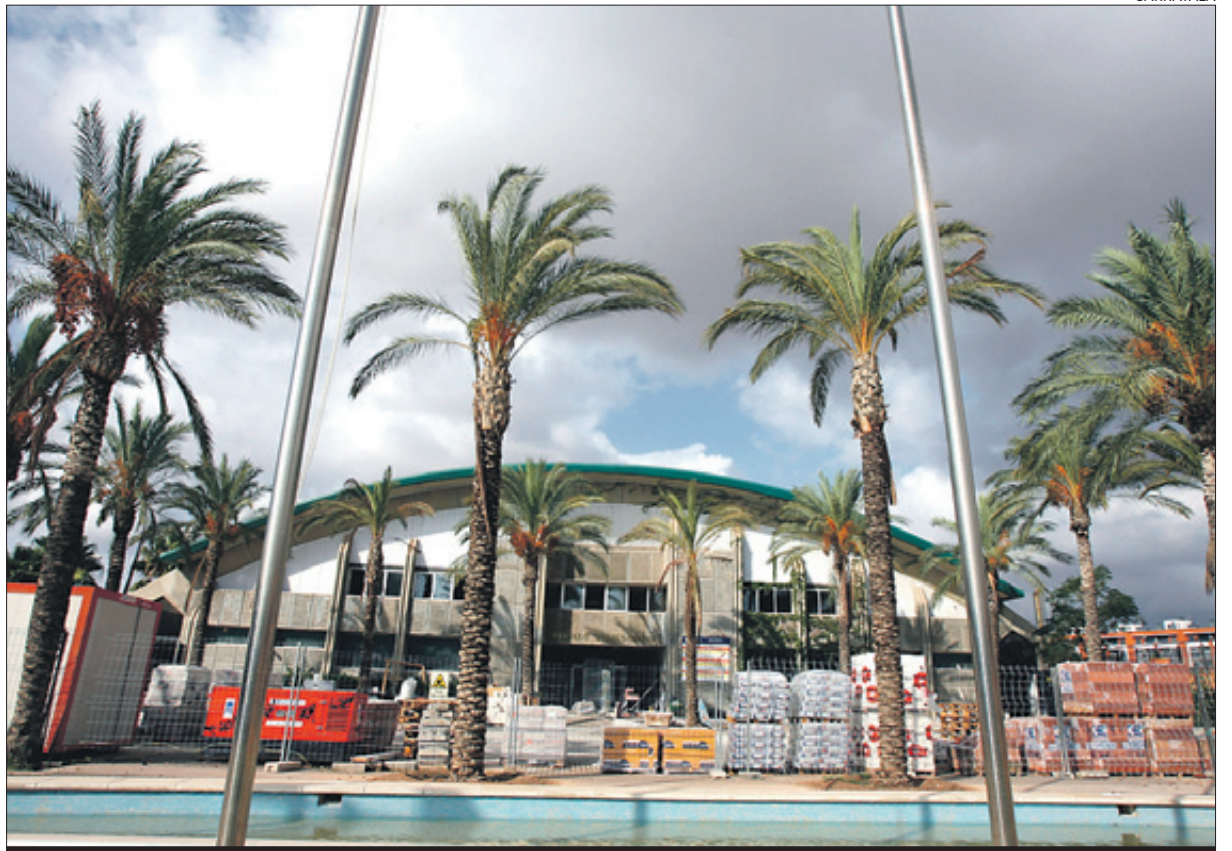
Imagen reciente del nuevo pabellón polideportivo de la Universidad de Alicante
