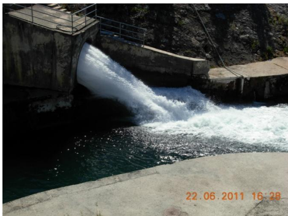
Слика 10.1: Испуст за биолошки минимум на ХЕ Требиње 2 за ријеку Требишњицу
