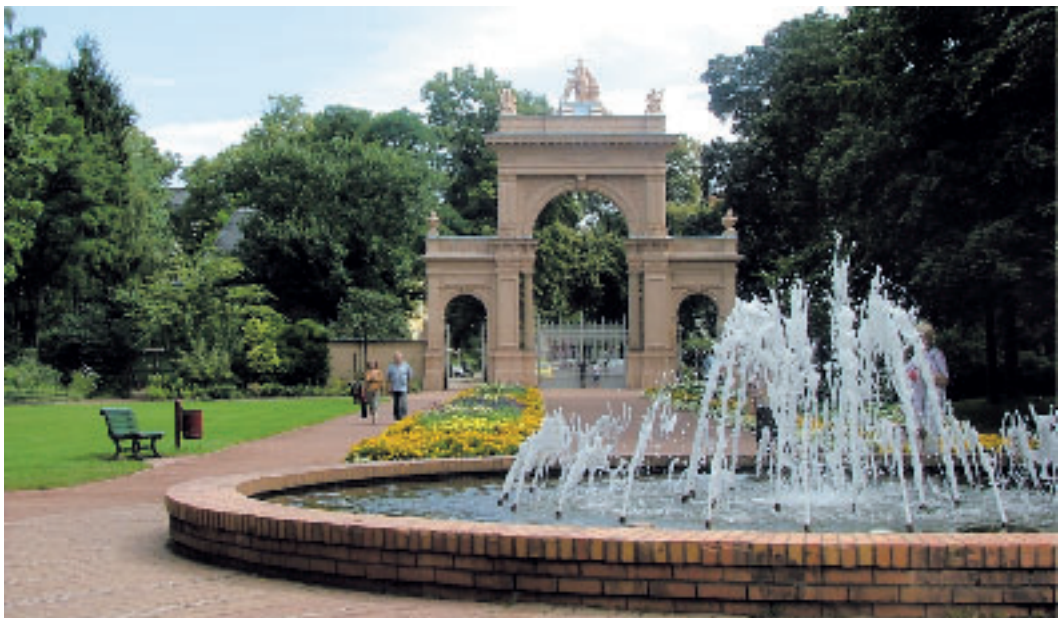
Das Bürgerparktor wurde nach umfangreicher Sanierung im August 2007 mit einem große Fest wiedereröffnet.
