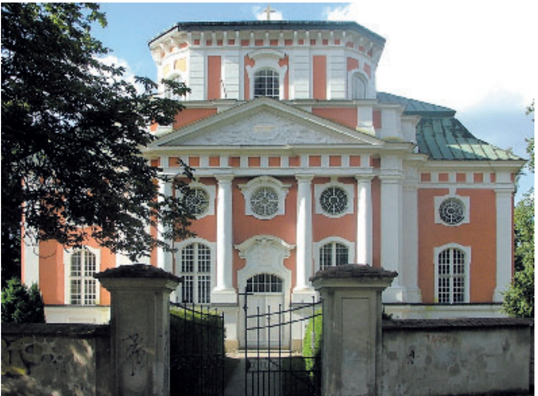
Von 1731 bis 1736 wurde die Bucher Schlosskirche, die als die schönste Barock-Kirche in Brandenburg galt, errichtet.
