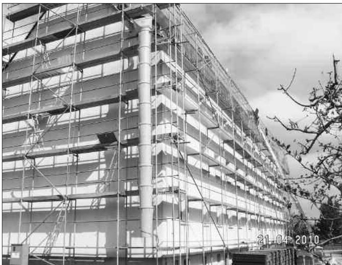
Dach- u. Fassadenerneuerung Bahnhofstraße 70 A/B
