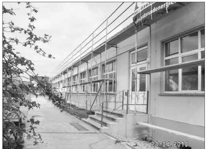
Montage der Solaranlage auf der Großküche
