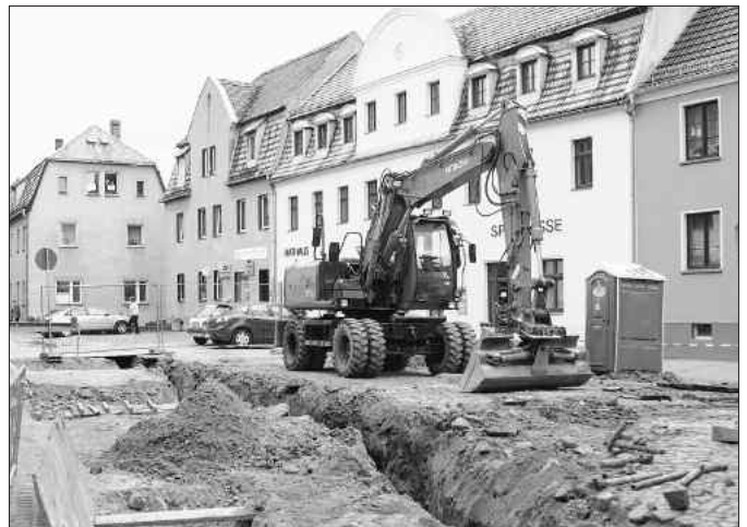
Straßenneubau Grimmaische Straße/Töpfermarkt
