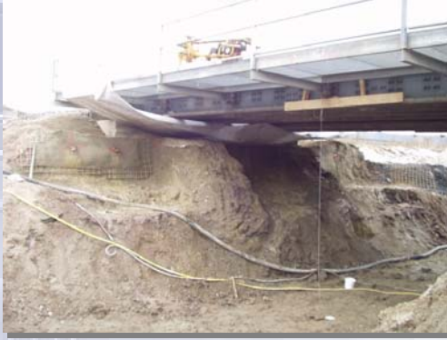
Hilfsbrücke im Los H1
