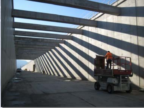
Fertiggestellte Wanne beim Portal Baumkirchen
