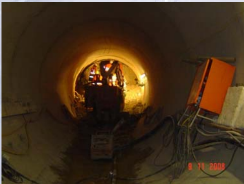
Ausbruch der Kaverne im Los H8
