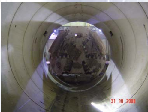
Rohrvortriebsmaschine im Rettungsstollen
