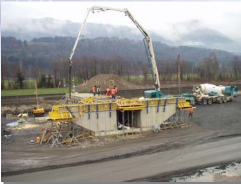
Betonierarbeiten für die Herstellung einer neuen Unterführung im Bereich Radfeld
