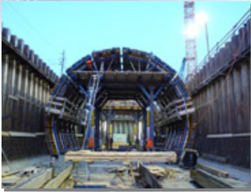
Aufbau Schalwagen im Los H2-2
