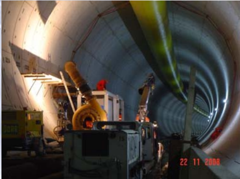
Relaispumpe - Montage der Förderleitung
