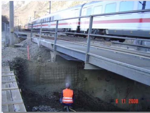
Spritzbetonsicherung Hilfsbrücke Los H8
