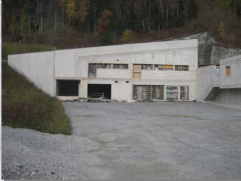
Das Betriebsgebäude in Fiecht wurde bereits Im Zuge der Tunnelbaumaßnahmen errichtet
