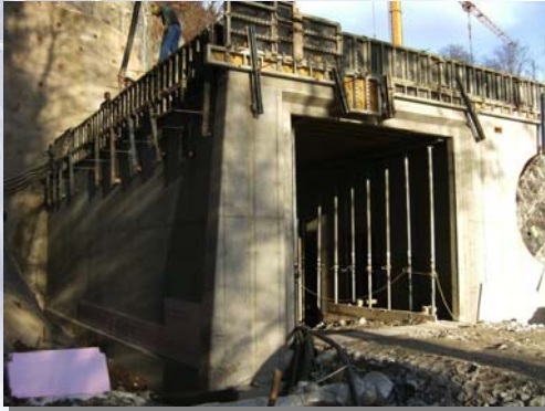
Herstellung eines Lüftergebäudes in Wiesing
