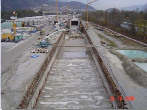
Wanne und Offene Bauweise; Blick Richtung Osten bzw. Jenbach
