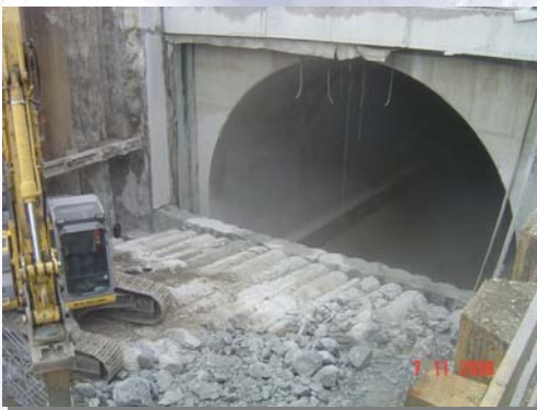
Abbruch der Bohrpfehlwand im Übergang des Loses H5 zu H4-3
