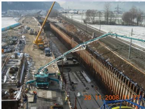
Baugrube mit betonierter Betonsohle und Spundwandsicherung
