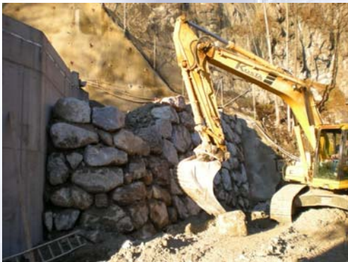
Steinschichtung im Bereich des Lüftergebäudes
