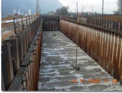
Gelenzte Baugrube im Baulos H2-2
