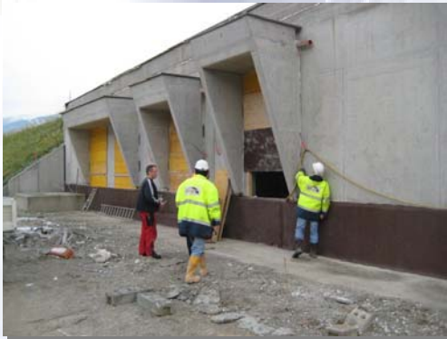
Betriebsgebäude in Baumkirchen
