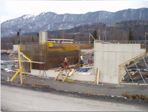
Bewehrungsarbeiten an der Wirtschaftswegunterführung
