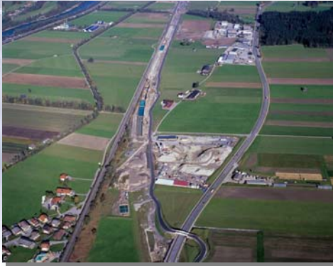
Luftbild Baulos H2-2 (Alpine Luftbild Innsbruck)
