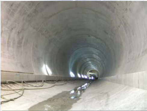
Haupttunnel mit fertiggestellter Innenschale
