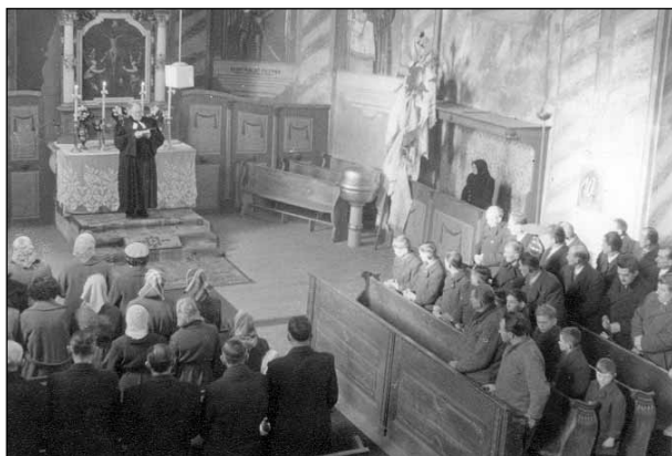
Bohoslužba pri príležitosti rekonštrukcie kostolnej veže v roku 1957
