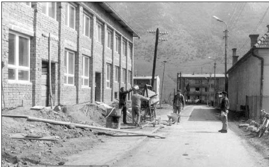
Výstavba kultúrneho domu v obci v r. 1979-1986
