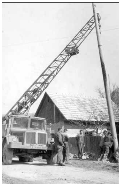
Komplexná rekonštrukcia siete el. energie v obci v r. 1961
