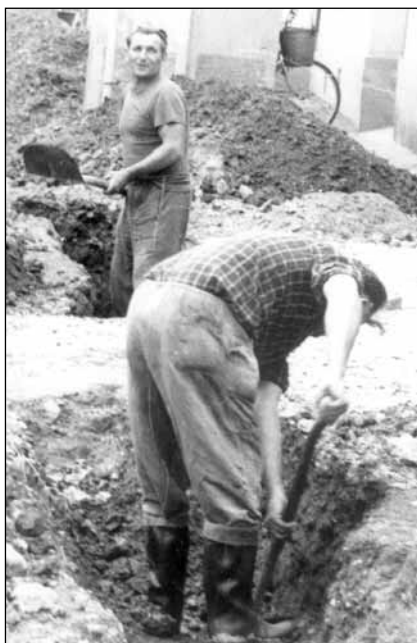
Výstavba vodovodu v obci v r. 1969
