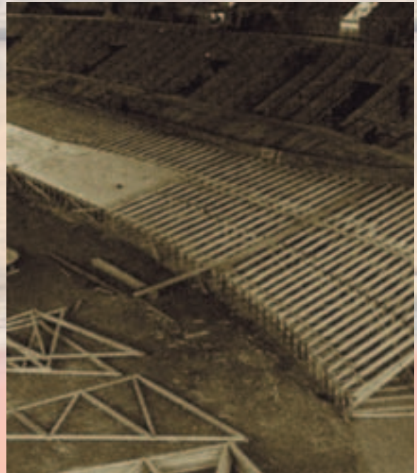
Die filigrane Pistenkonstruktion bewährte sich.
