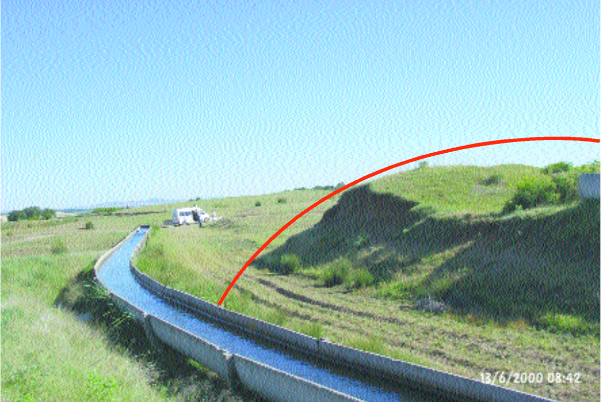
Gevgililer Tümülüsleri: \approx 3.000 yıllık. Kanalet geçirebilmek için tümülüs toprağının yarısı alınmış.
