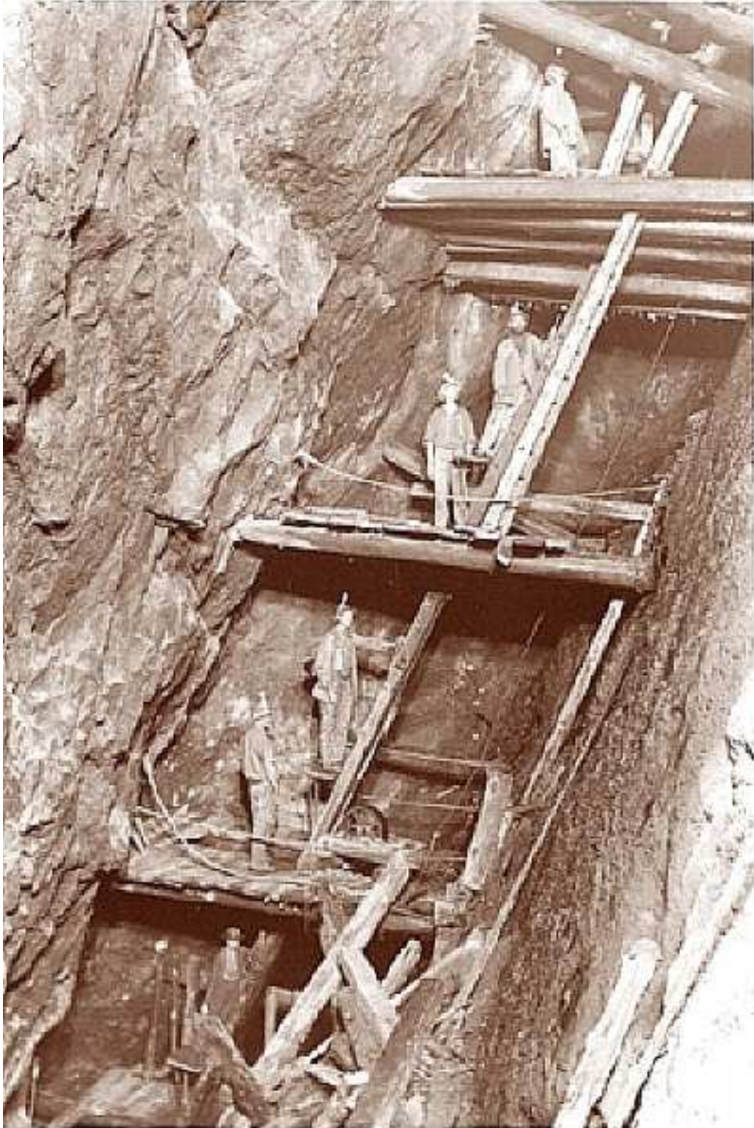
Abb.7 : Die berühmte Fahrkunst der Dolcoath Mine in Cornwall Quelle : Sammlung des Bergbaumuseums in Truro
