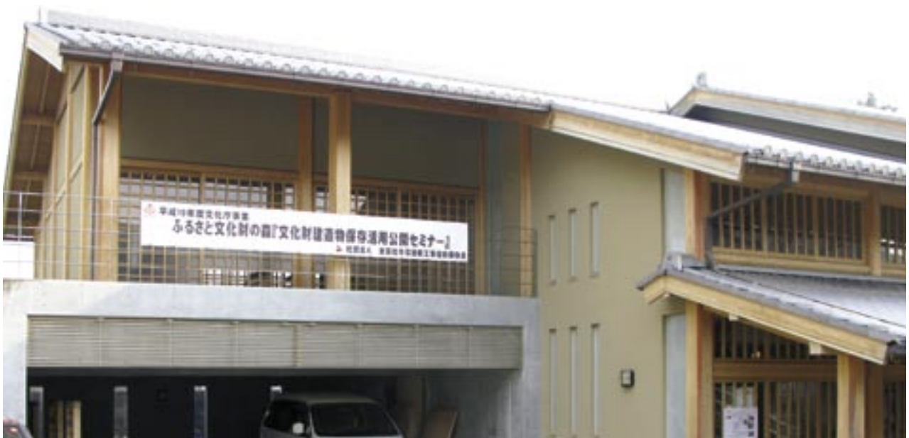
文化財建造物保存技術研修センター
