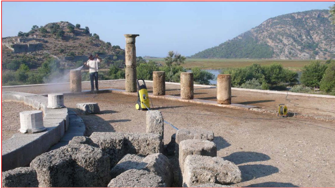
Res. 14: Teras Tapınağı, bloklarının konservasyon çalışmaları
