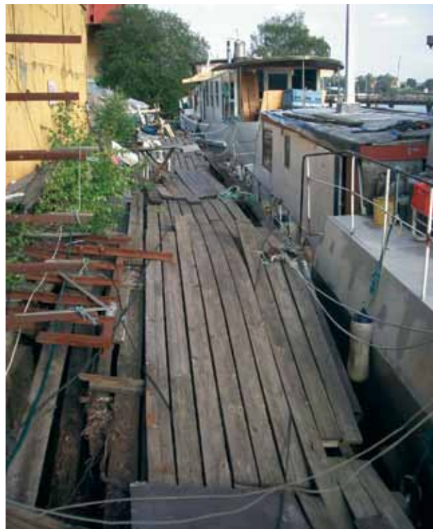
En helt ny 220 meter lång kaj har byggts vid Djurgårdsvärvet (bilder före och efter).
