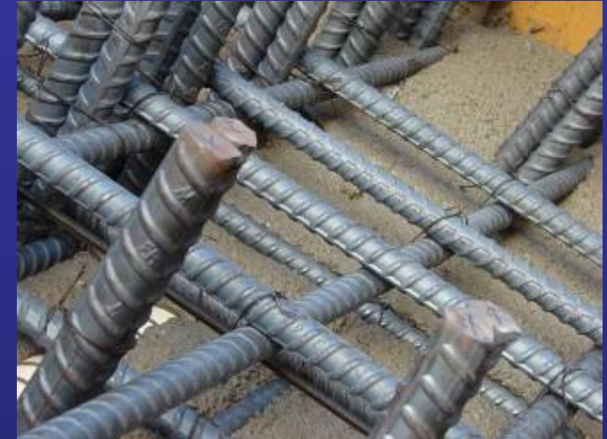
SCC Pour Mock-up
