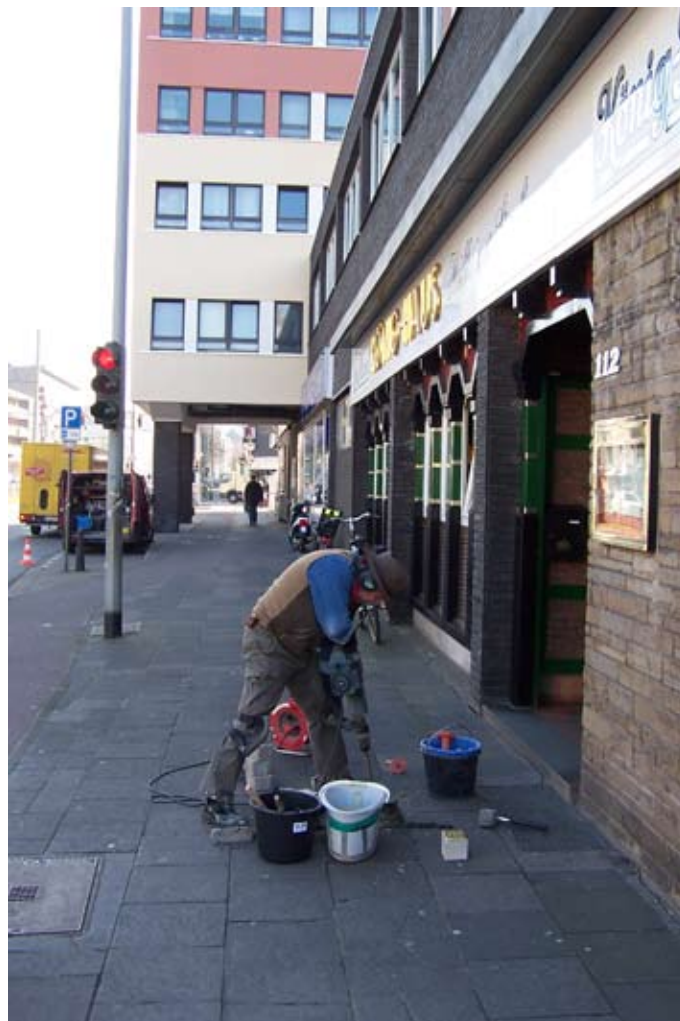
Gunter Demnig bohrt in das Pflaster auf der Mülheimer Straße
