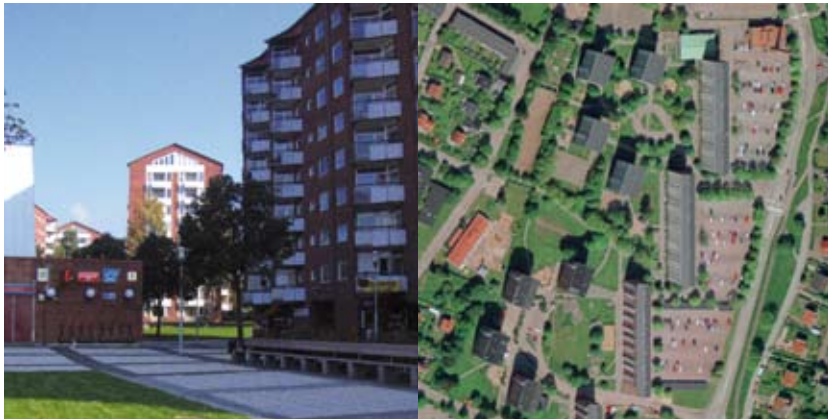
Storskalig bebyggelse - foto och ortofoto Brunnsbo
