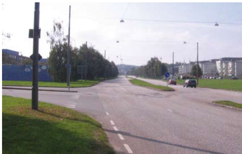
Litteraturgatan - en barriär som skär genom stadsdelen. Här finns ett reserverat område för spårväg
