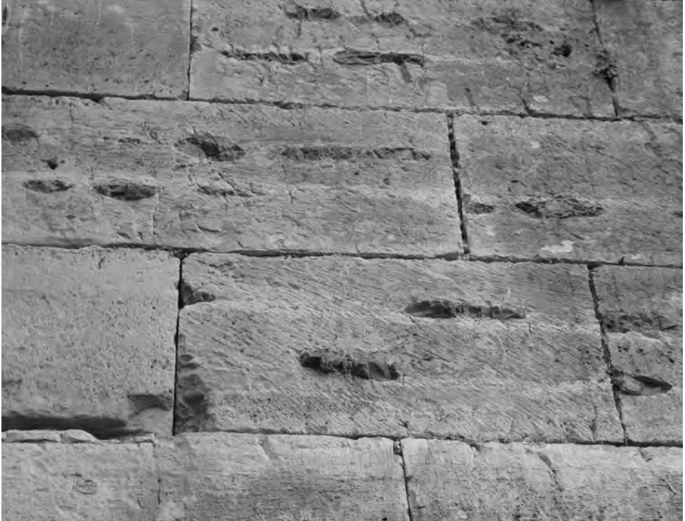
Fig. 22 – Vue rapprochée d'une partie du Crac des Chevaliers montrant les blocs de calcaire avec des filons de silex.
