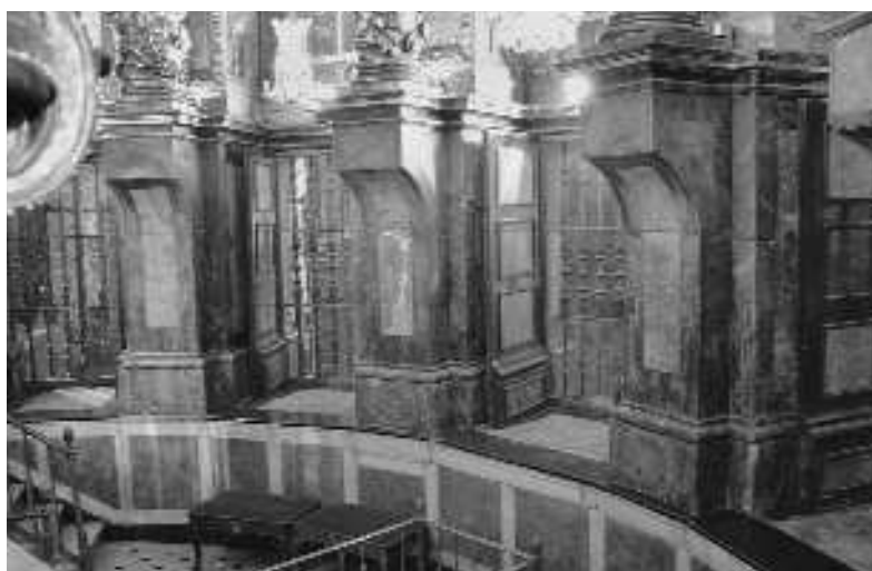
Fig. 4. Cierre de los vanos de la Sacristía Vieja.
