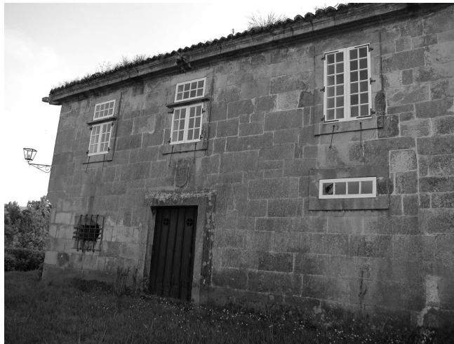
Tramo izquierdo de la fachada principal.
