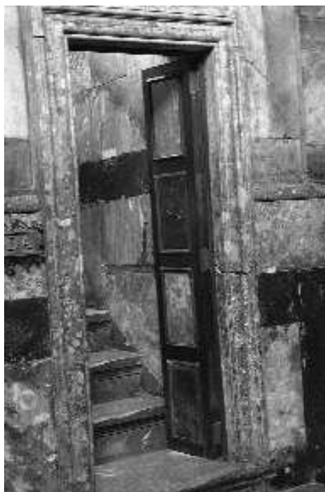
Fig. 2. Detalle de una de las puertas del acceso al pasillo que conduce al camarín.
