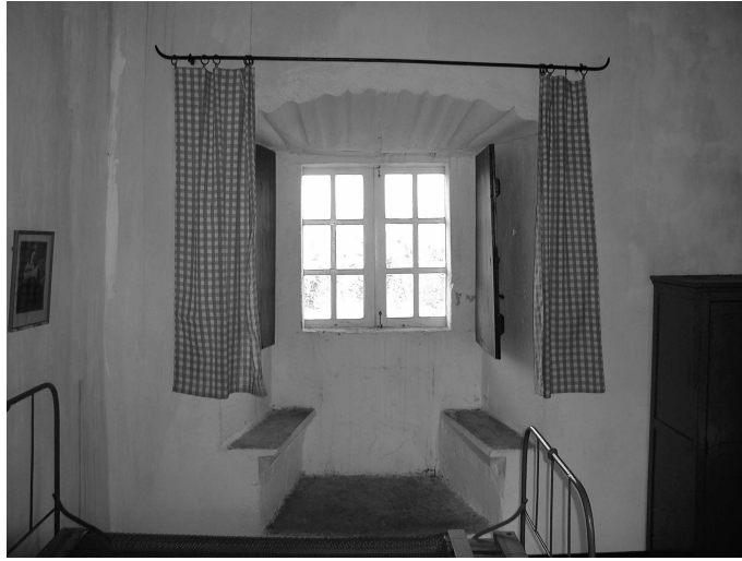
Ventana oriental en el cuarto alto de la torre.
