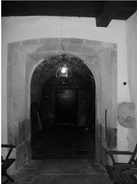
Antigua puerta de paso a la fachada posterior.
