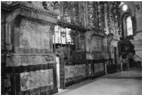
Fig. 8. Detalle del zócalo de la girola.
