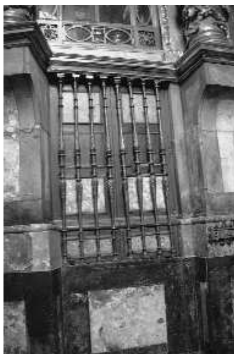
Fig. 3. Cierre de uno de los vanos de la Sacristía Vieja.
