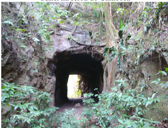
Túnel na serra do Calaboca
