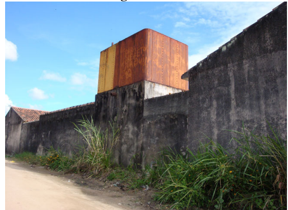
Caixa d'água em Araruama
