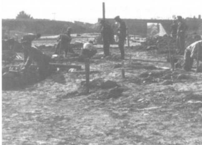
Trasse der Fernverkehr-Schnellstraße
