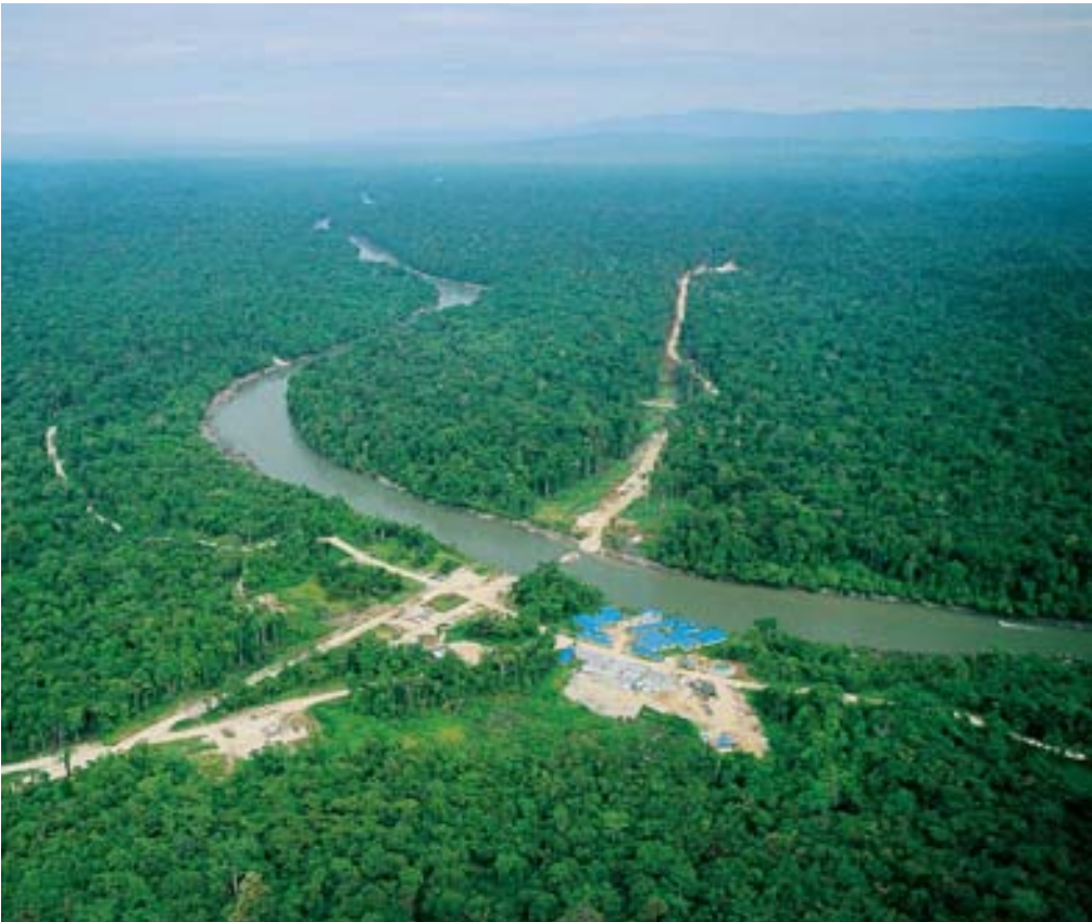
Pose d'un pipeline en Papouasie-Nouvelle-Guinée archives SPIE.
