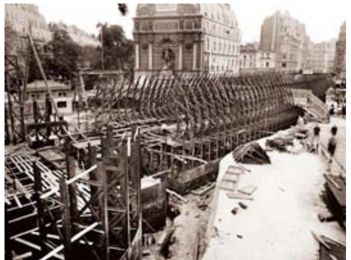
Paris (VI e ), place Saint-Michel, construction du métropolitain, les fermes du boulevard Saint-André (auj. rue Danton) avant le fonçage,
