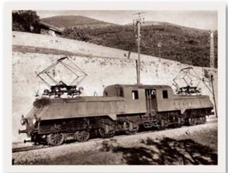
Électrification du P.L.M. (Paris-Lyon-Méditerranée) : locomotive Auvert-Ferraud
