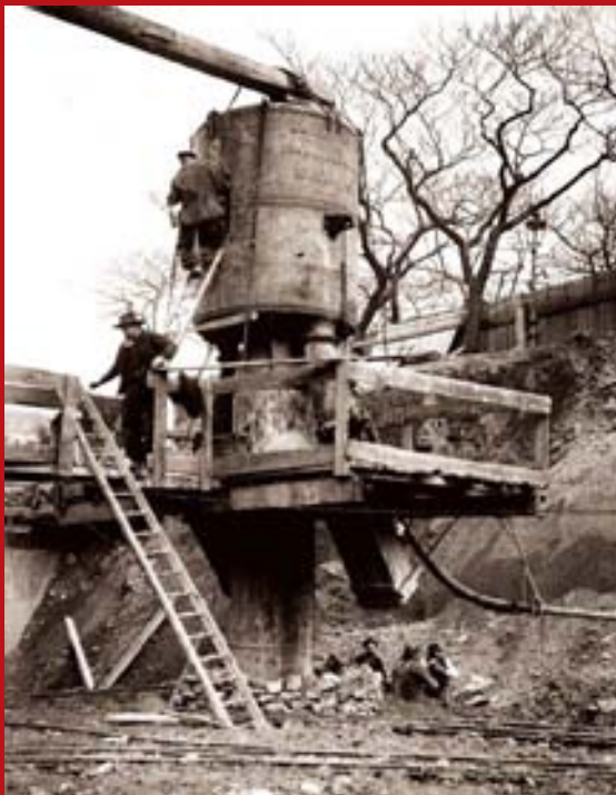
Construction du métro de Paris Entrée des ouvriers dans un sac à air, © Bayer / Roger-Viollet.
