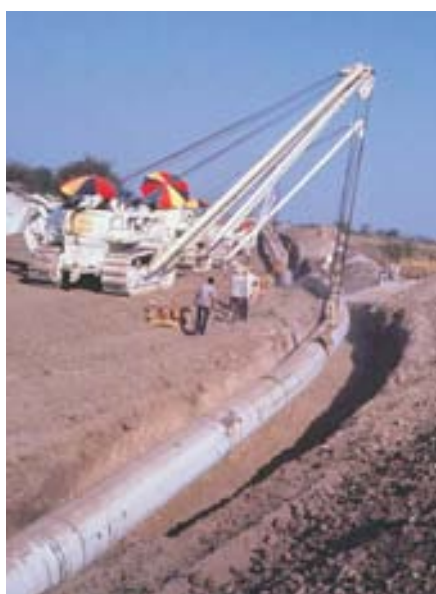
Construction du pipeline HBJ, Inde
