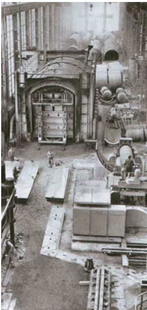
Vue partielle de l'atelier de grosse chaudronnerie des chantiers de Chalon-sur-Saône archives Schneider.
