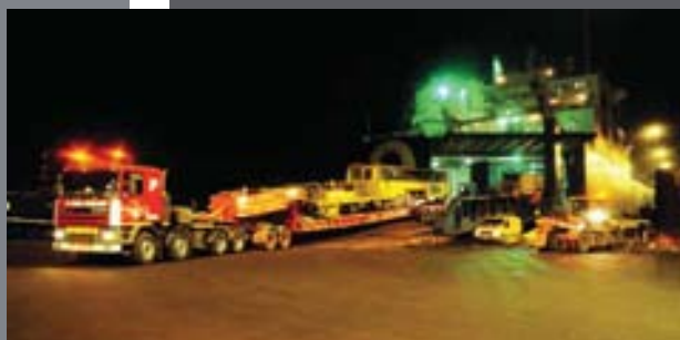
Arrivée du matériel de chantier archives SPIE.
