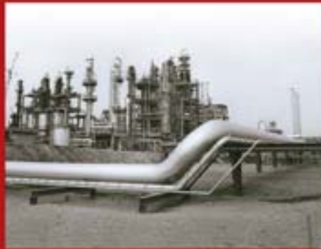
Usine de liquéfaction de gaz naturel, Skikda, Algérie, archives SPIE.
