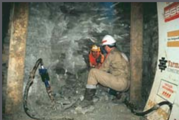
1 er décembre 1990, jonction du tunnel de service
