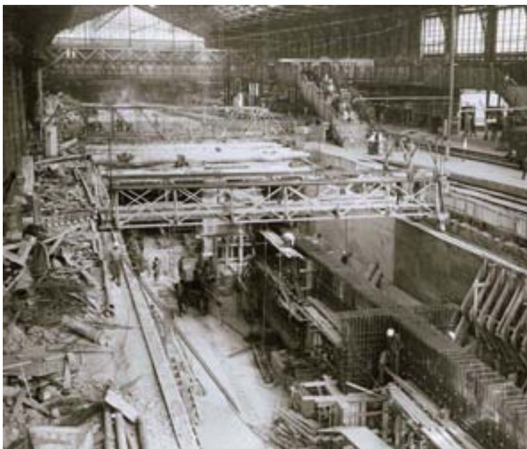
Gare souterraine de Paris-Austerlitz © H. Baranger et C e .
