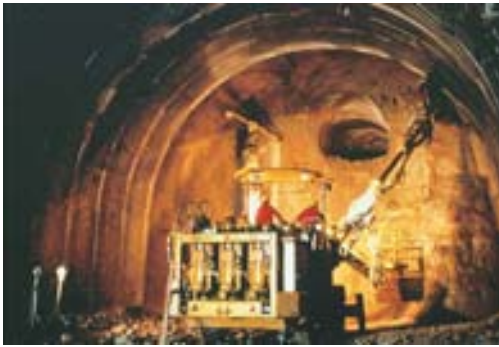
Tunnel « Vue des Alpes », Suisse archives SPIE.
