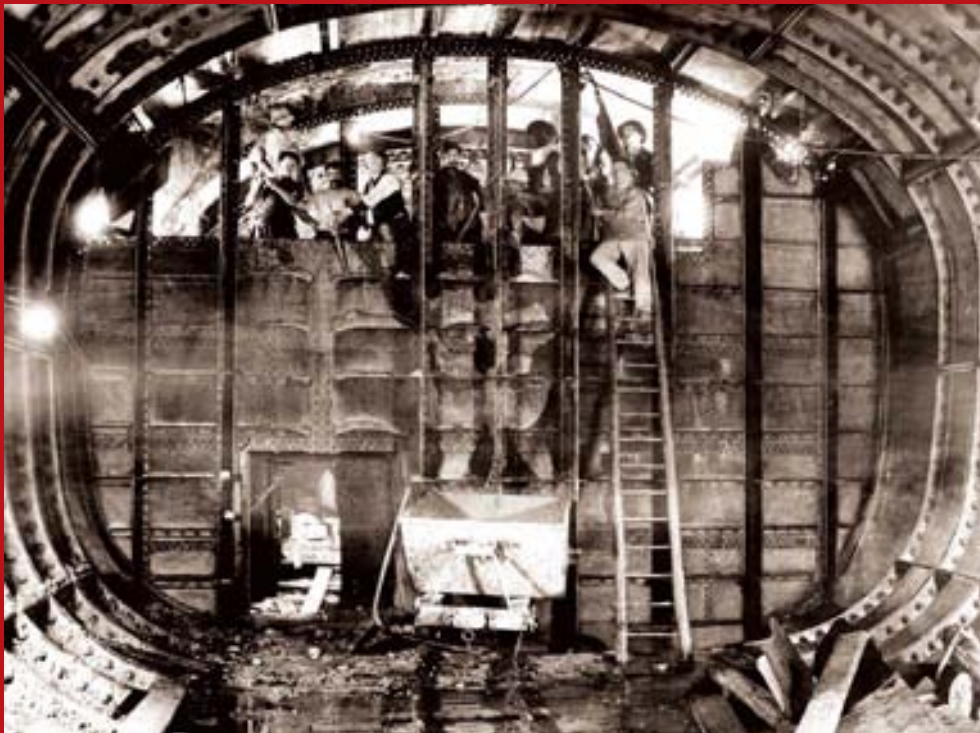
Caisson sous la Seine à la hauteur de la station « Cité », débouchonnage du masque, © Collection Roger-Viollet.
