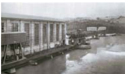
Usine-barrage de Seyssel archives Schneider.
