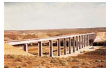
Viaduc de l'Olifant's River. Chemin de fer Sishen Saldanha, Afrique du Sud : mises en place par poussage archives SPIE.
