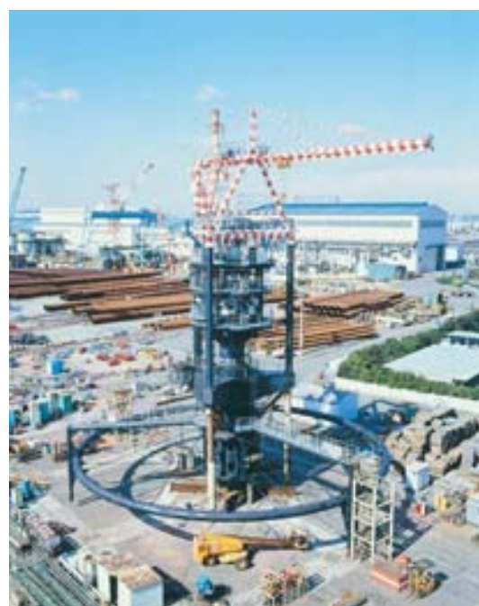
Superstructure d'un poste d'amarrage et de chargement de tanker destinée à TOTAL en Chine
