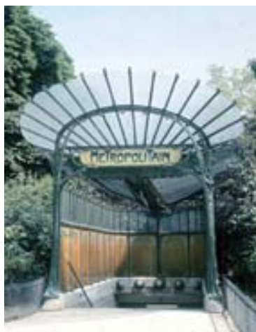
Station de métro Porte Dauphine par Hector Guimard (1867-1942), architecte et décorateur français. © Collection Roger-Viollet.
