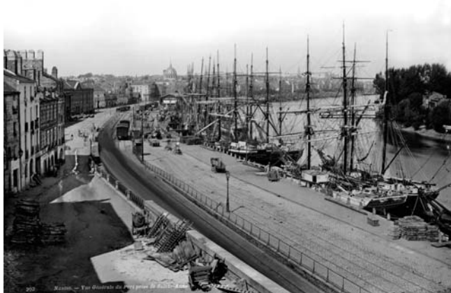
Vue générale du port de Nantes au XIX e siècle © ND / Roger-Viollet
