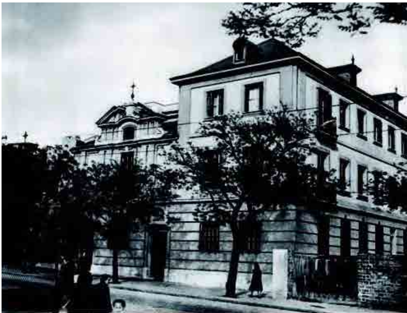
Huarte se encargó de la construcción, en 1945, de una de las iglesias más castizas de Madrid: Santa María de la Cabeza.
