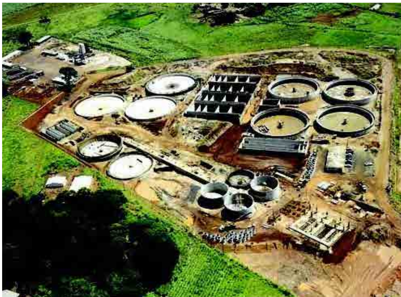
La construcción de la depuradora de Ribeirão Preto, en Brasil, ha sido una de las obras relacionadas con el área “agua y medio ambiente” más significativas, puesto que nació para dar servicio a 600.000 habitantes.
