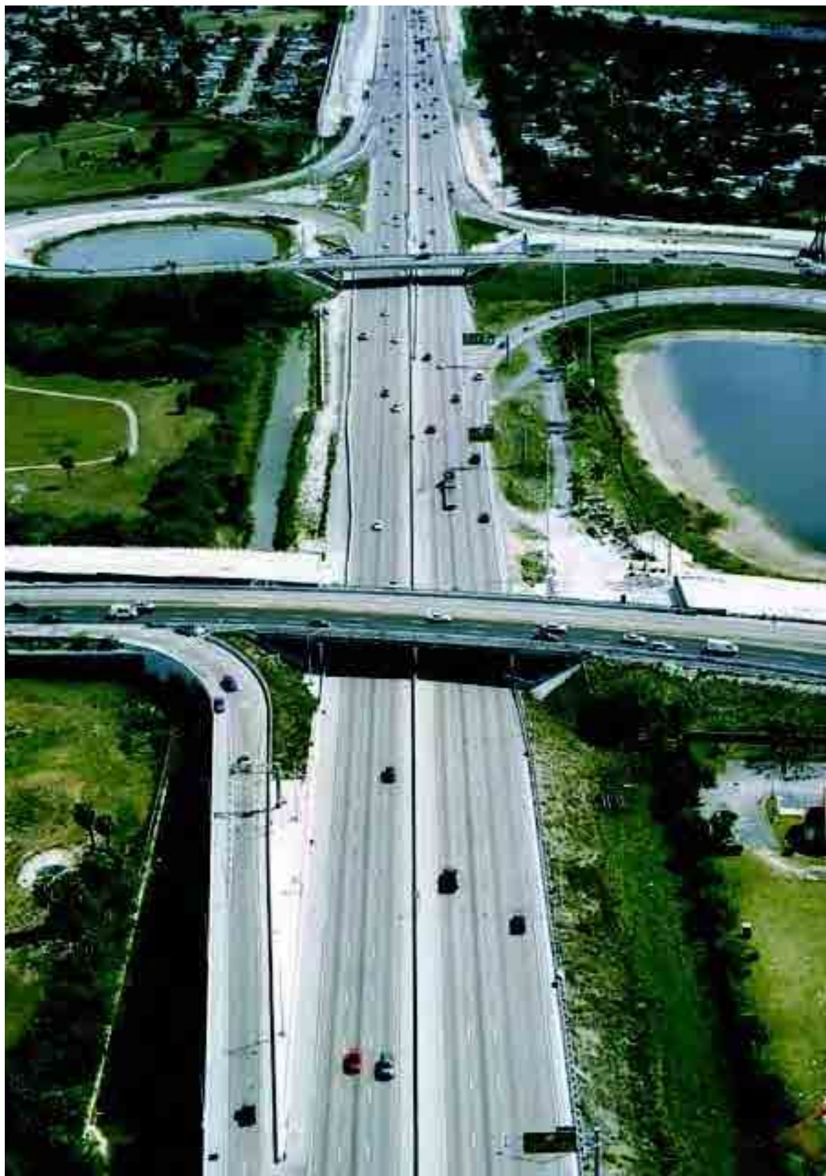
OHL está considerada en diversos ranking locales como una de las principales constructoras del Sureste de Estados Unidos. En la foto, una de las autopistas en las que ha realizado obras: La Ronald Reagan.
