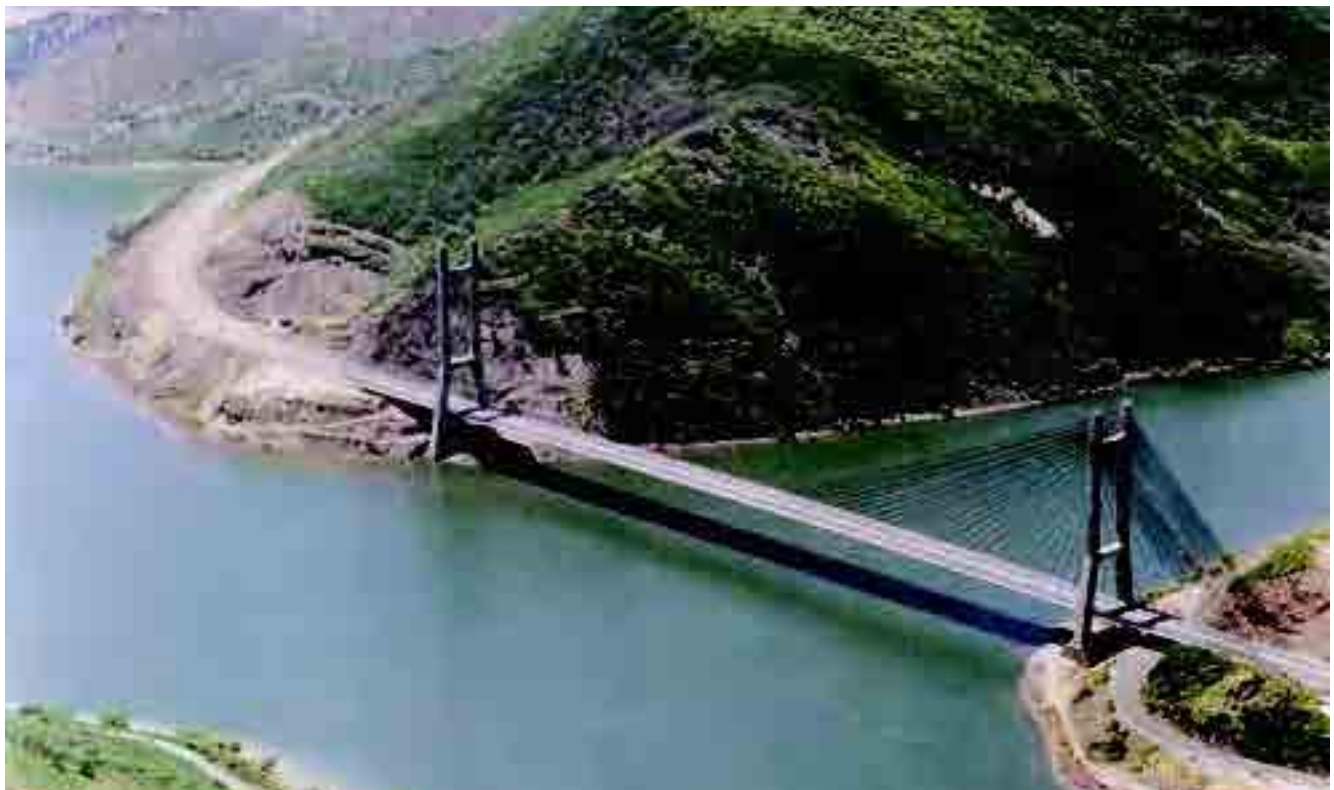
Puente Fernández Casado en la autopista León-Campomanes, entre la meseta castellana y Asturias.
