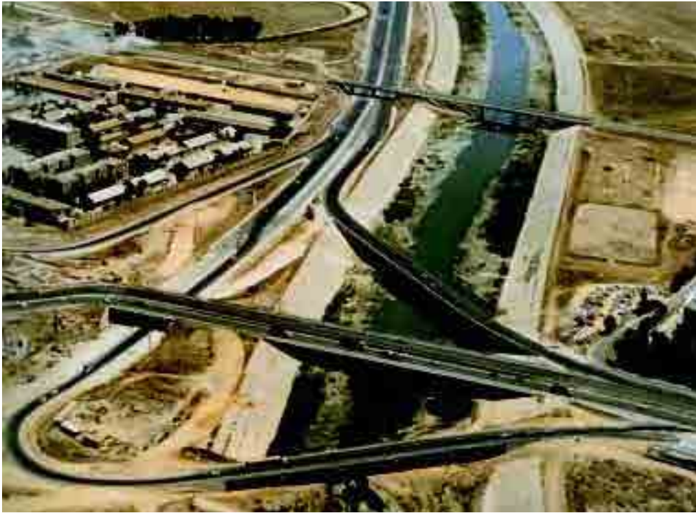
El 64% de la nueva contratación realizada por Obrascón en 1990 correspondió a obra civil, como línea de negocio más destacada de toda la cartera. En la imagen, Autovía de circunvalación Este II en Sevilla.
