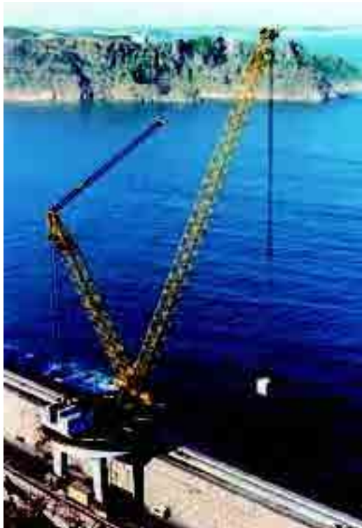
Obras en el Dique Príncipe de Asturias, puerto de El Musel, Gijón.
