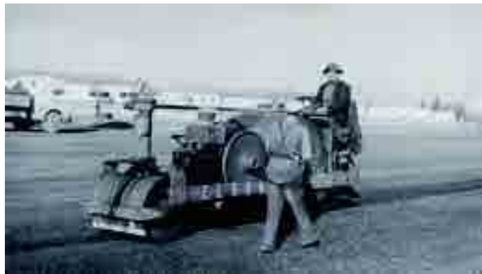
El plan de modernización de carreteras emprendido en 1951 permitió el asfaltado de muchos viejos caminos empedrados e iniciar la mejora de las comunicaciones viarias. En la imagen, obras en un camino empedrado.
