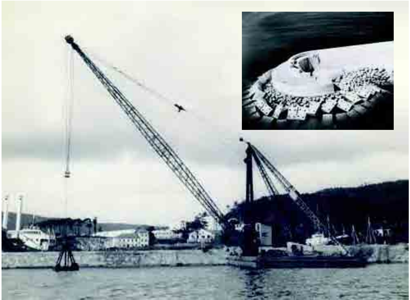
En los años 50, Obrascón continuó centrada en su mercado tradicional de obra civil, con predominio de las portuarias. En las imágenes, una de las cabrias utilizadas por la compañía en esta década para trasladar grandes volúmenes de materiales en sus obras y cubípodos en la base naval de Rota, en 1959. Abajo, obras en el puerto de Santander, en 1967 y dragado en el puerto de Cádiz, en 1962.
