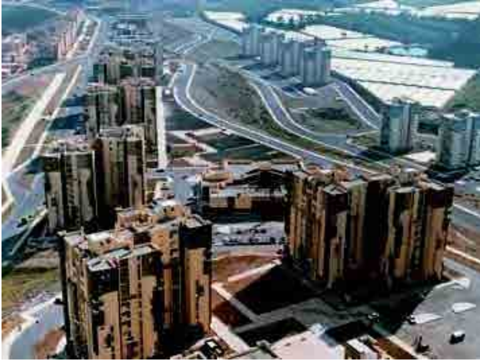
Urbanización del Polígono Residencial Jinámar, en Las Palmas, una de las mayores y más lucrativas obras de Obrascón: 1.760 viviendas, locales comerciales y urbanización de las parcelas.
