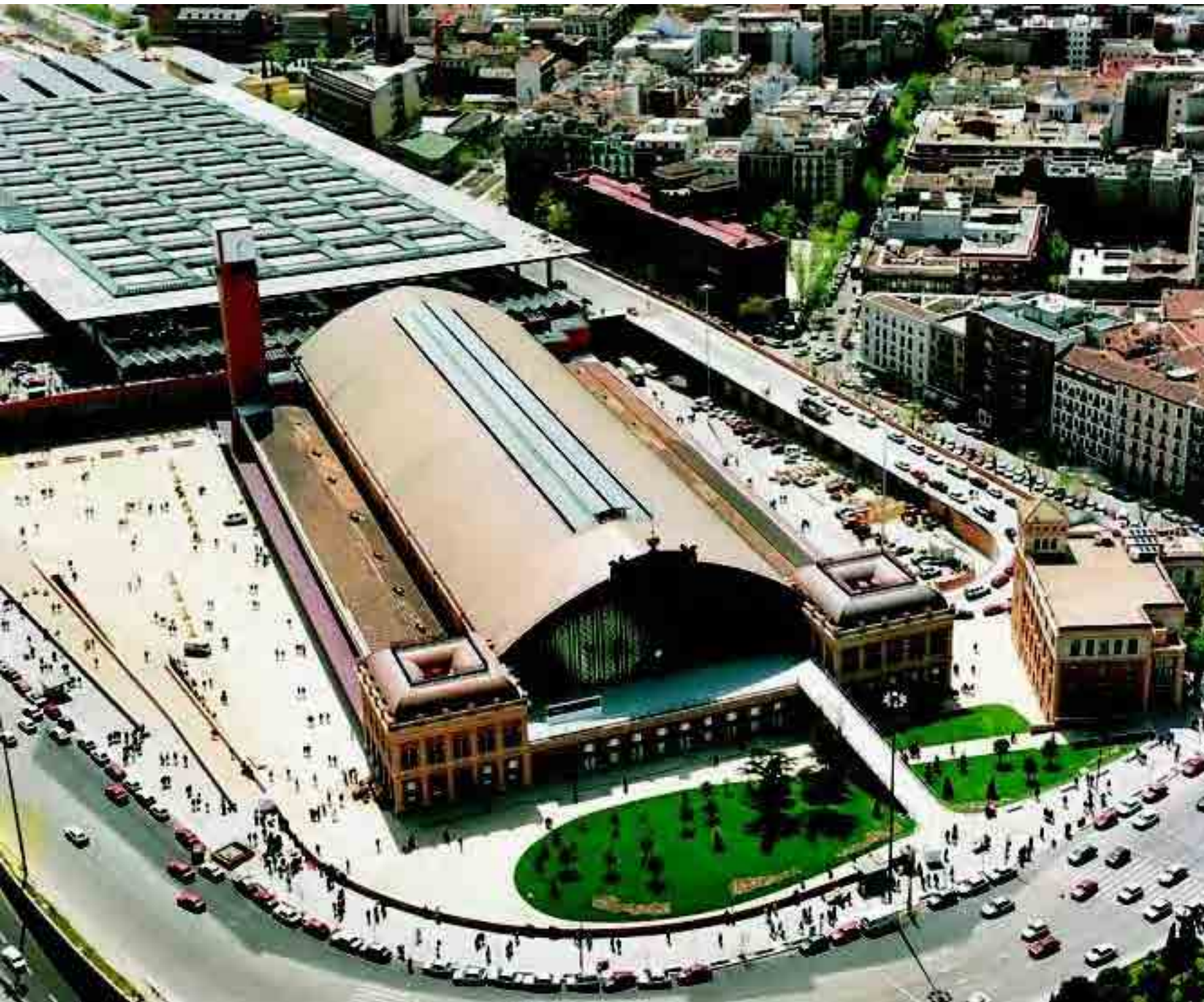
Estación de Atocha, cuyas obras de restauración para acoger la cabecera madrileña de la línea ferroviaria del AVE Madrid-Sevilla, fueron entregadas en 1992.
