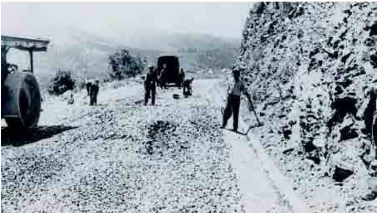
El plan de modernización de carreteras emprendido en 1951 permitió el asfaltado de muchos viejos caminos empedrados e iniciar la mejora de las comunicaciones viarias. En la imagen, obras en un camino empedrado.
