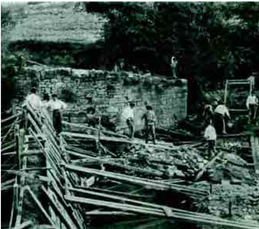
Brigadas de trabajadores en la construcción de la presa navarra de Urdaniz, en los años 30.
