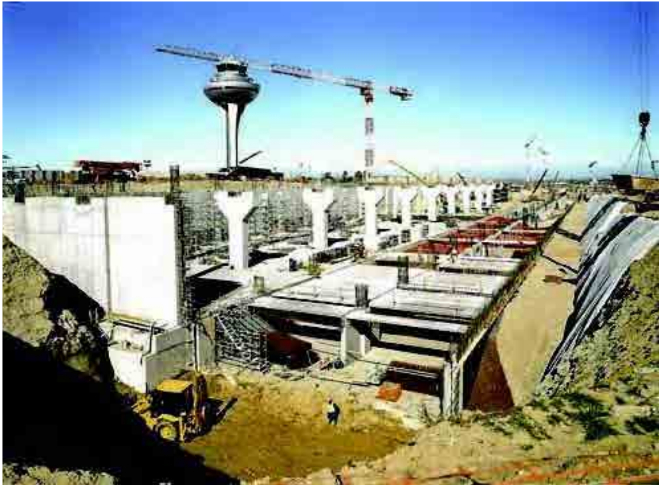
Durante 2001, un 35% del total de presupuesto contratado correspondió a edificación. Entre las adjudicaciones más destacadas se encontraba el edificio Satélite de la nueva Terminal 4 del Aeropuerto Madrid-Barajas, que OHL construyó para Aena.
