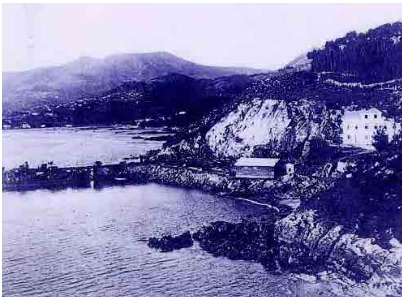
De la cantera de Meira, propiedad de Obrascón, se extraía la piedra para la construcción de los muelles de Vigo.
