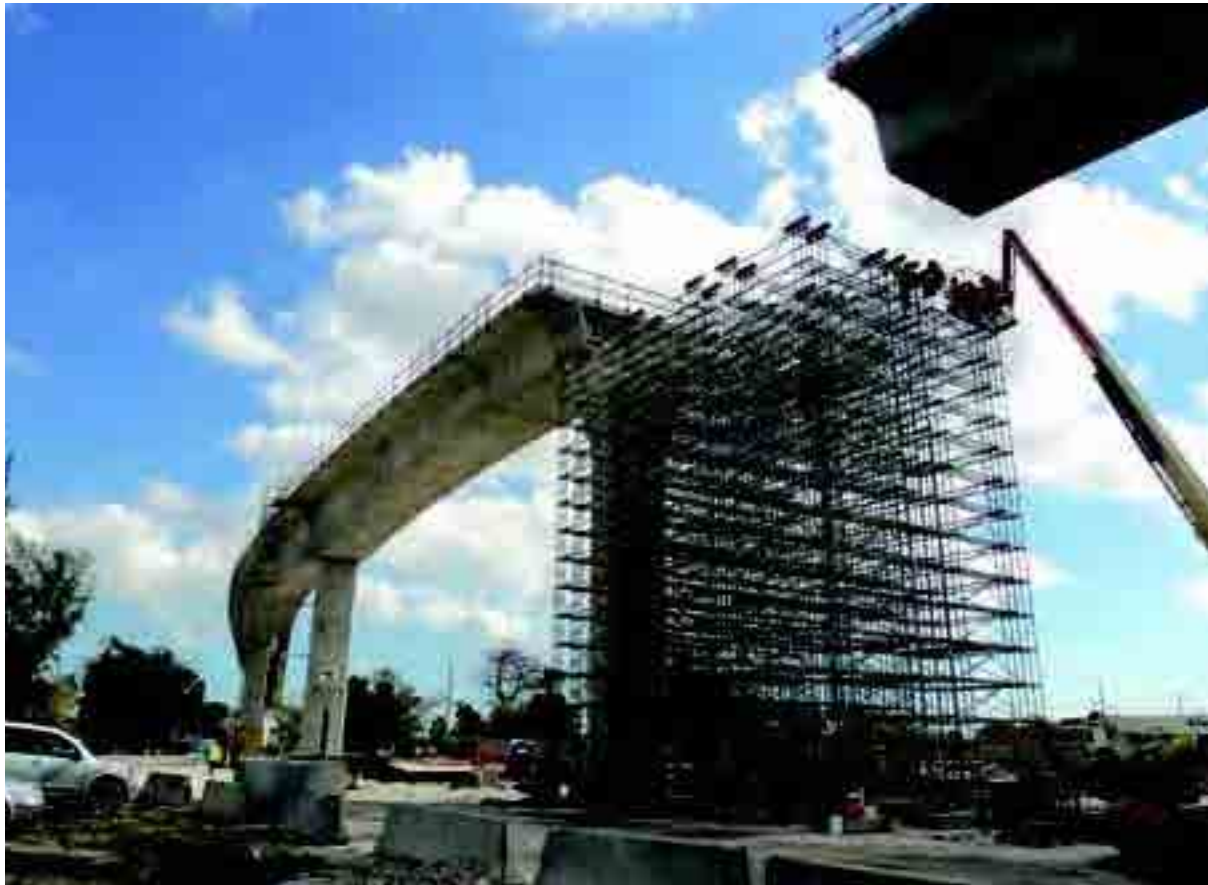
Optimizar la seguridad de los empleados en los procesos de construcción es una de las prioridades de la I+D+i sectorial. En la imagen, obras de OHL en el metro de Miami a su aeropuerto.
