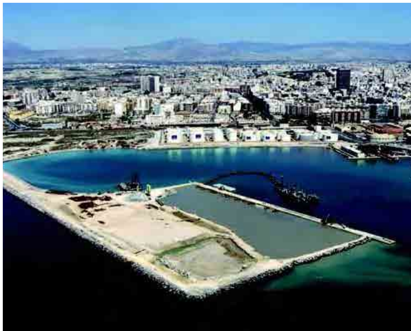
Terminal para graneles sólidos del Puerto de Alicante.
