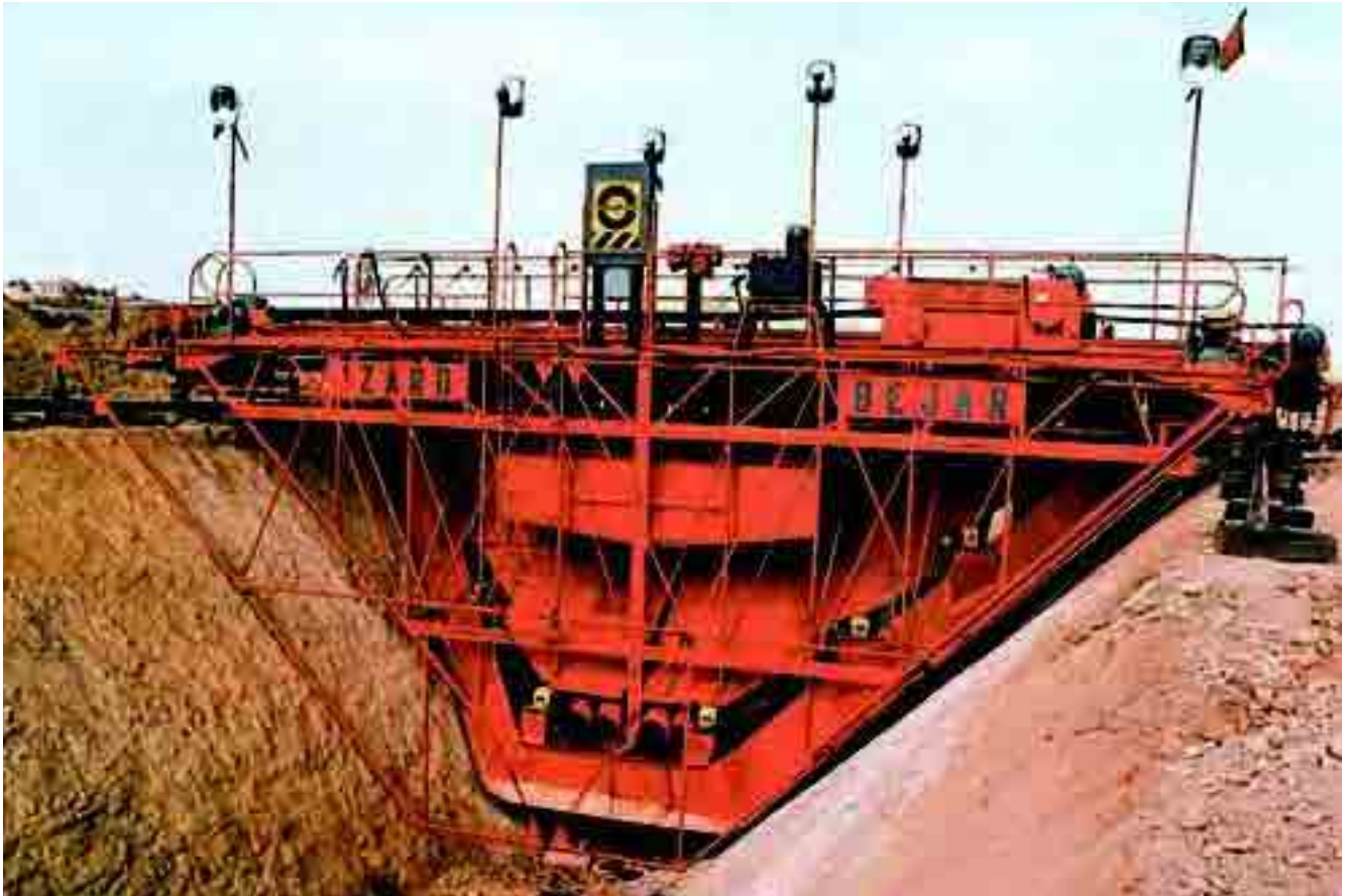
Encofrado deslizante motorizado de Obrascón utilizado en la construcción del Canal de Crevillente, una de las obras principales acometidas en los 80.
