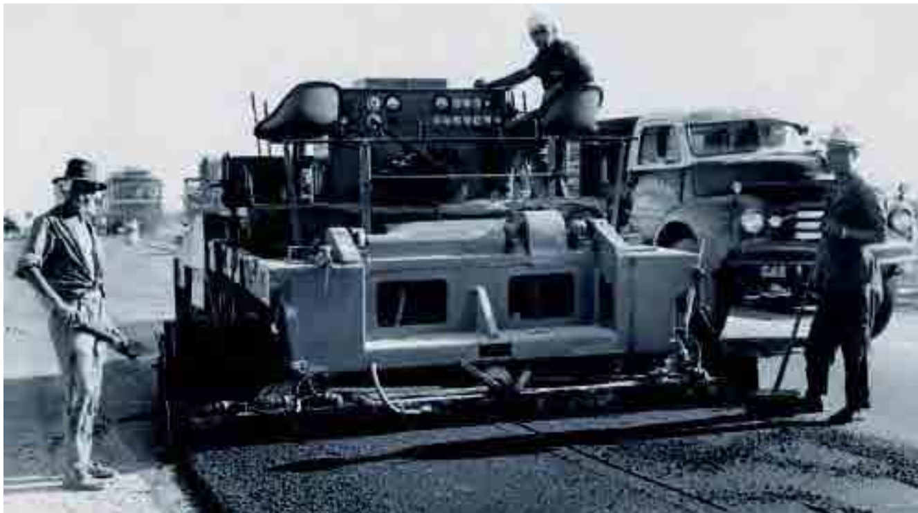
El plan de modernización de carreteras españolas de 1950 impulsó fuertemente la calidad de estas infraestructuras, así como la tecnología de las máquinas para el asfalto. En la foto, último modelo de una extendedora Alfelder autopropulsada, recién importada de Alemania.
