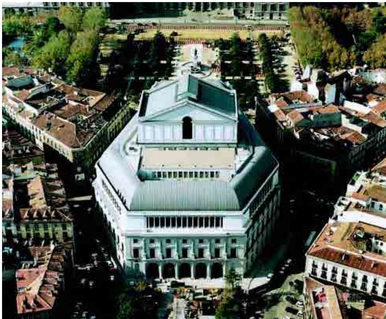
La restauración del Teatro Real de Madrid, llevada a cabo por Huarte, es una de las obras emblemáticas de la marca OHL.
