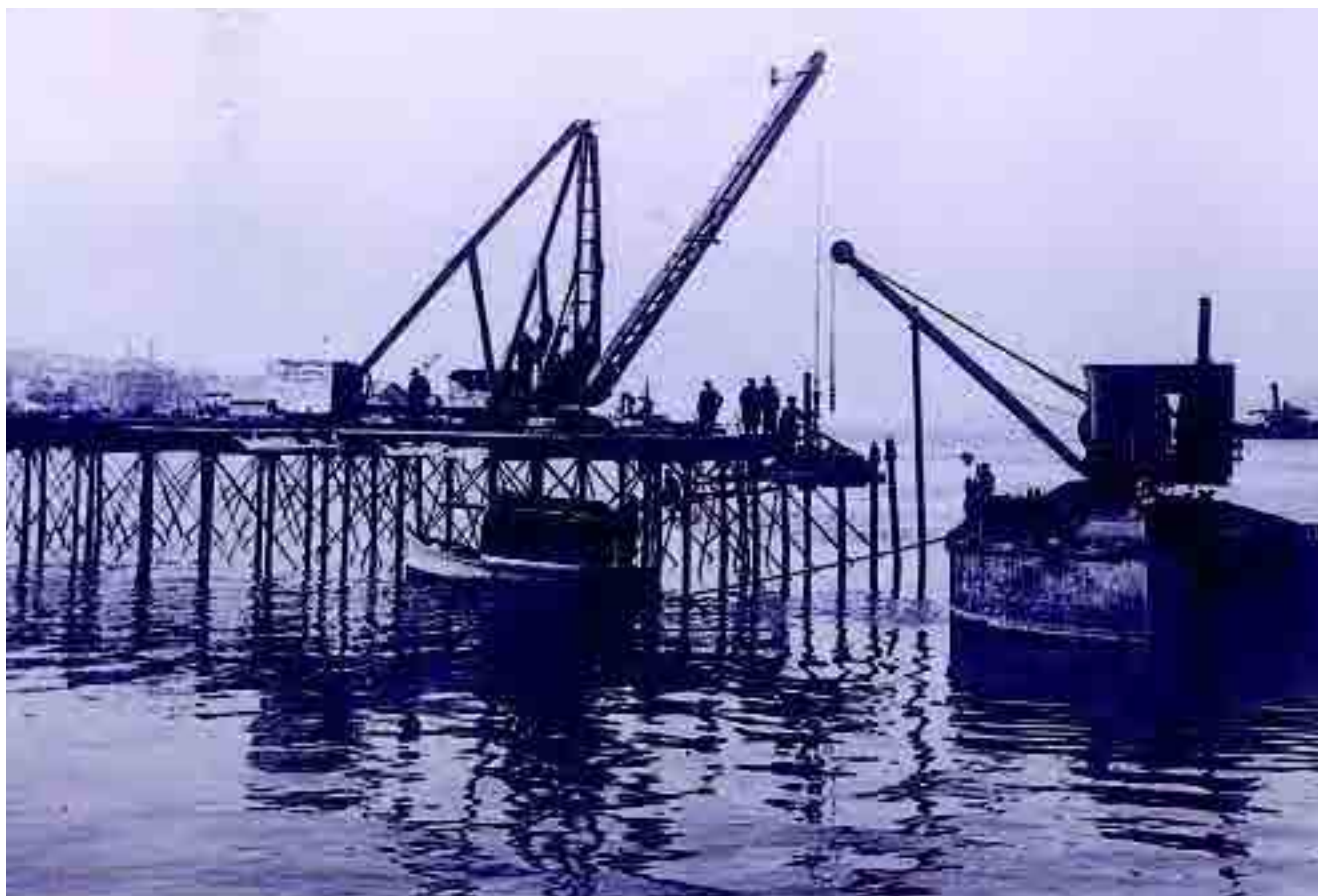
Estas dos instantáneas muestran la construcción del muelle de Ribera de Areal, en Vigo. Arriba, el frente y, abajo, las vías y pavimento, ambas obras realizada por Obrascón en los años 30.
