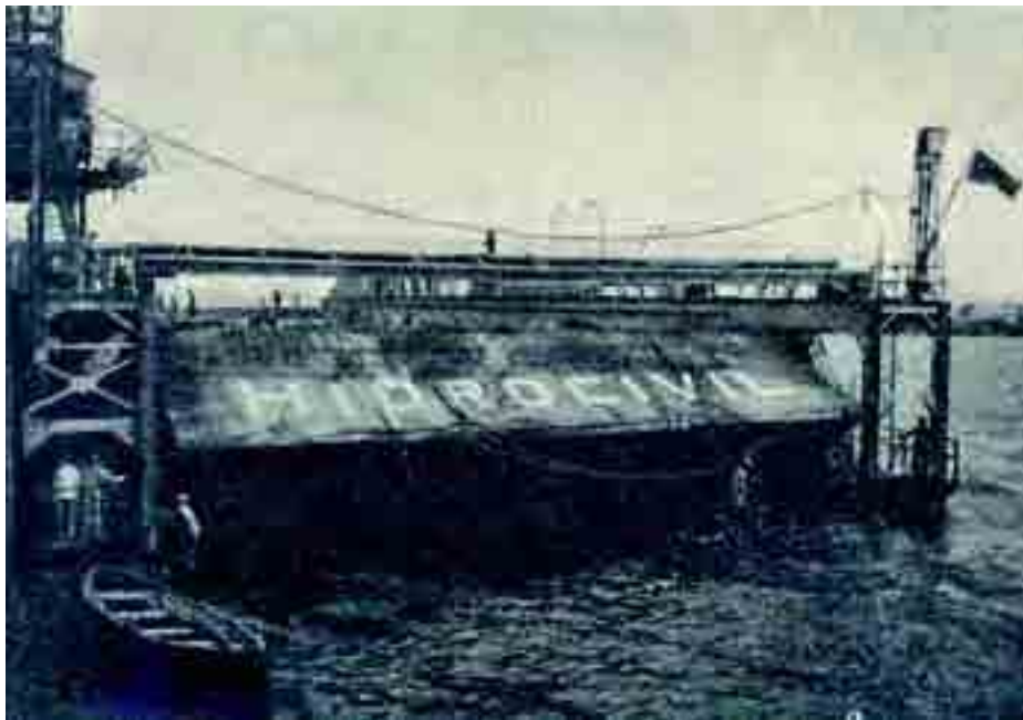
Obrascón abordó, al final de los años 20, obras de gran envergadura como el dique seco Nuestra Señora del Rosario, en el Puerto de Cádiz. La botadura, en 1929, del primero de los 13 cajones del dique constituyó un hito tecnológico. Se trataba del más grande construido en el mundo hasta el momento, con 3.200 toneladas de peso.
