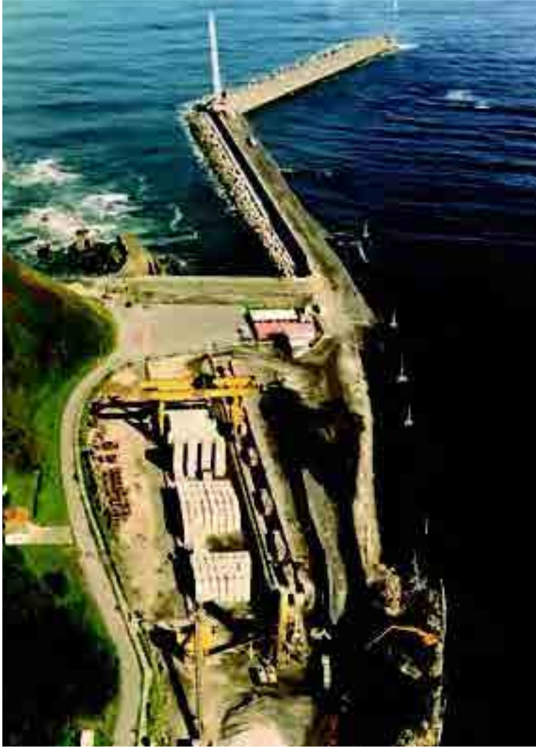
El puerto de San Esteban de Pravia está ligado a la historia de Obrascón. Casi ochenta años separan uno de sus primeros contratos para dragar su canal de acceso y las obras de acondicionamiento del citado canal en 1998, cuando fue tomada esta foto.
