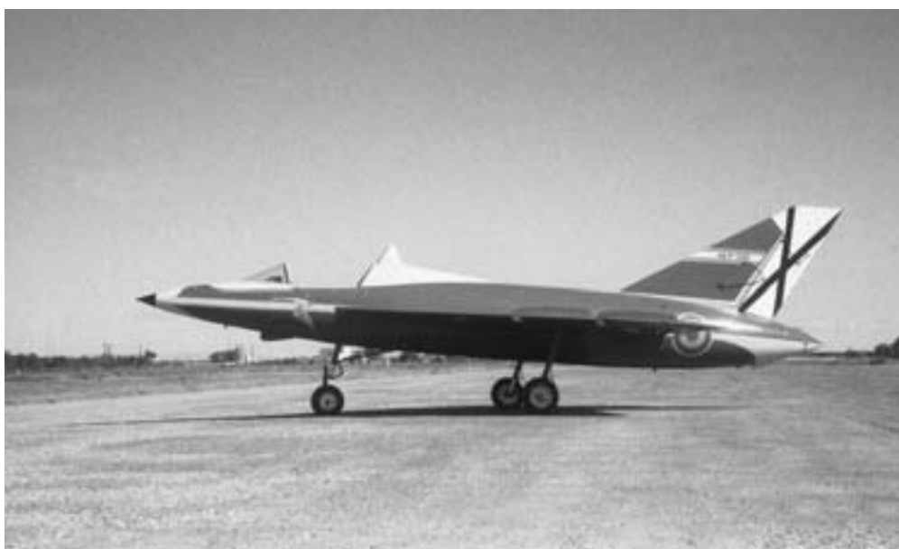
Arriba; La Hispano Aviación construyó un planeador de ensayos con la configuración del HA-300 que designó HA-300P. Imagen tomada durante la prueba de resistencia de su ala (12 de diciembre de 1958). Izquierda: el planeador HA-300P en San Pablo (21 de octubre de 1959).
