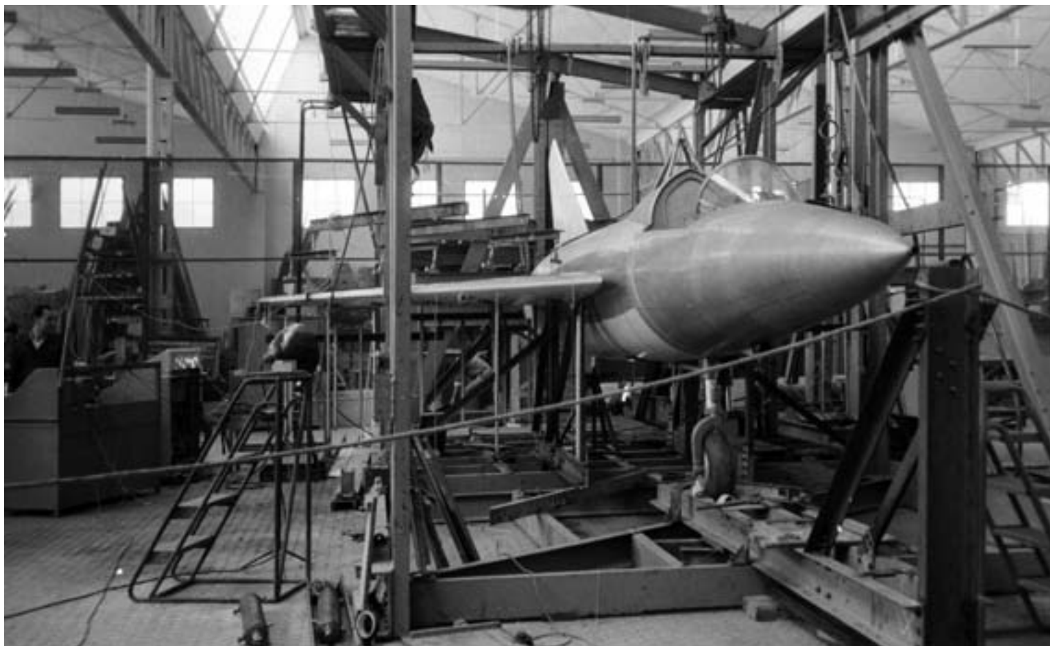
Arriba; La Hispano Aviación construyó un planeador de ensayos con la configuración del HA-300 que designó HA-300P. Imagen tomada durante la prueba de resistencia de su ala (12 de diciembre de 1958). Izquierda: el planeador HA-300P en San Pablo (21 de octubre de 1959).
