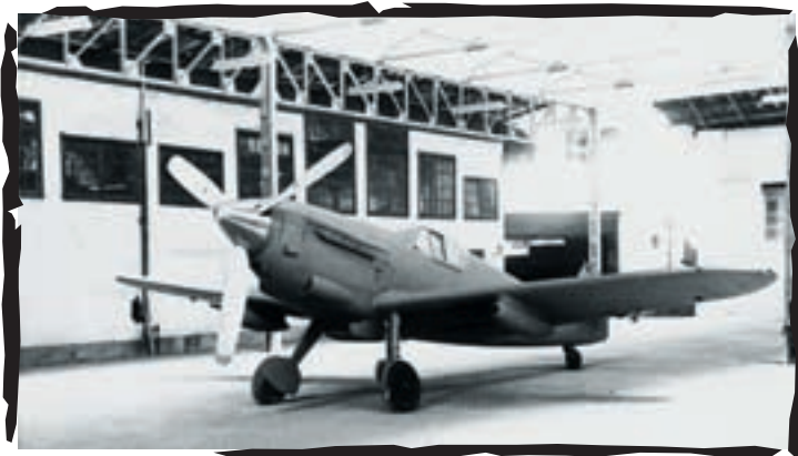
Hasta finales de 1952 la Hispano Aviación no pudo hacer entrega de ninguno de los ejemplares de la versión española del Bf 109 que se le habían encargado en 1941. El de la foto fue el prototipo de los que deberían haber sido entregados con ametralladoras CETME de 12'7 mm, situadas en góndolas bajo los planos, y que jamás lo fueron (CASA).
