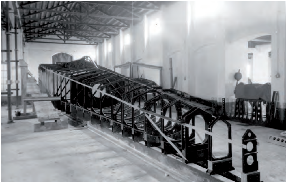
Montaje de cuadernas del casco en la grada en Cádiz. (Archivo CASA).
