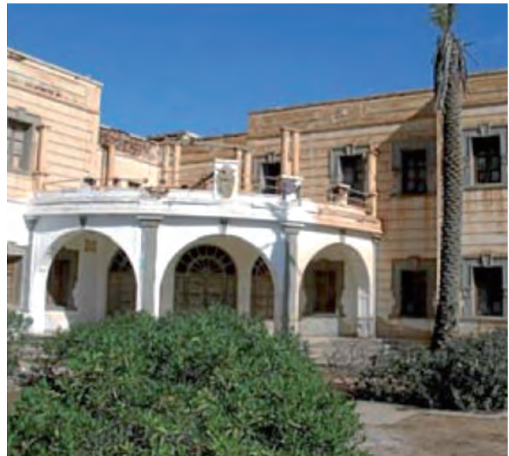
Antigua pagaduría de Sidi Ifni.
