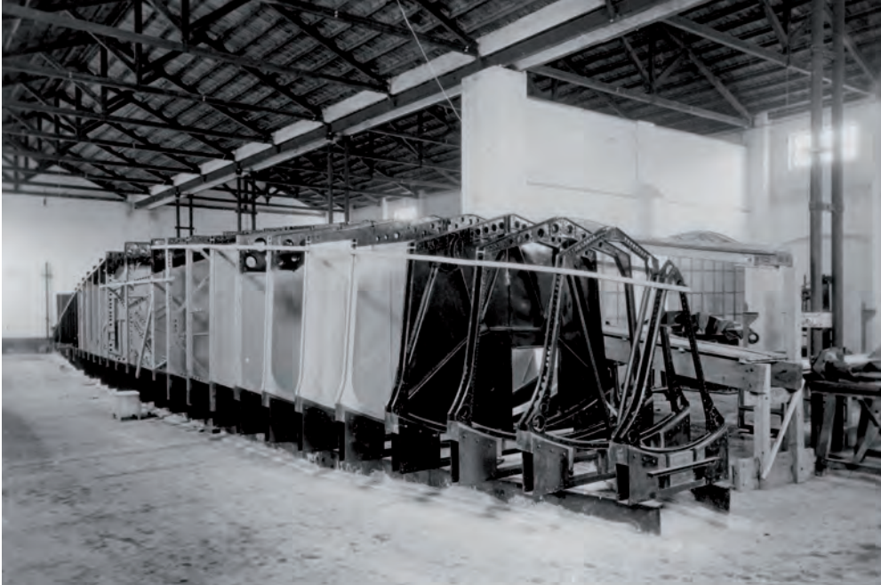
Detalle de cuadernas y compartimentación del casco del Numancia. (Archivo CASA).
