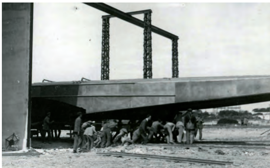
Casco del hidroavión Numancia llegando al hangar de la factoría de CASA en Puntales.
