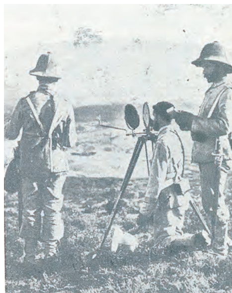
Una estación heliográfica transmitiendo órdenes desde la 2ª caseta durante una operación.
