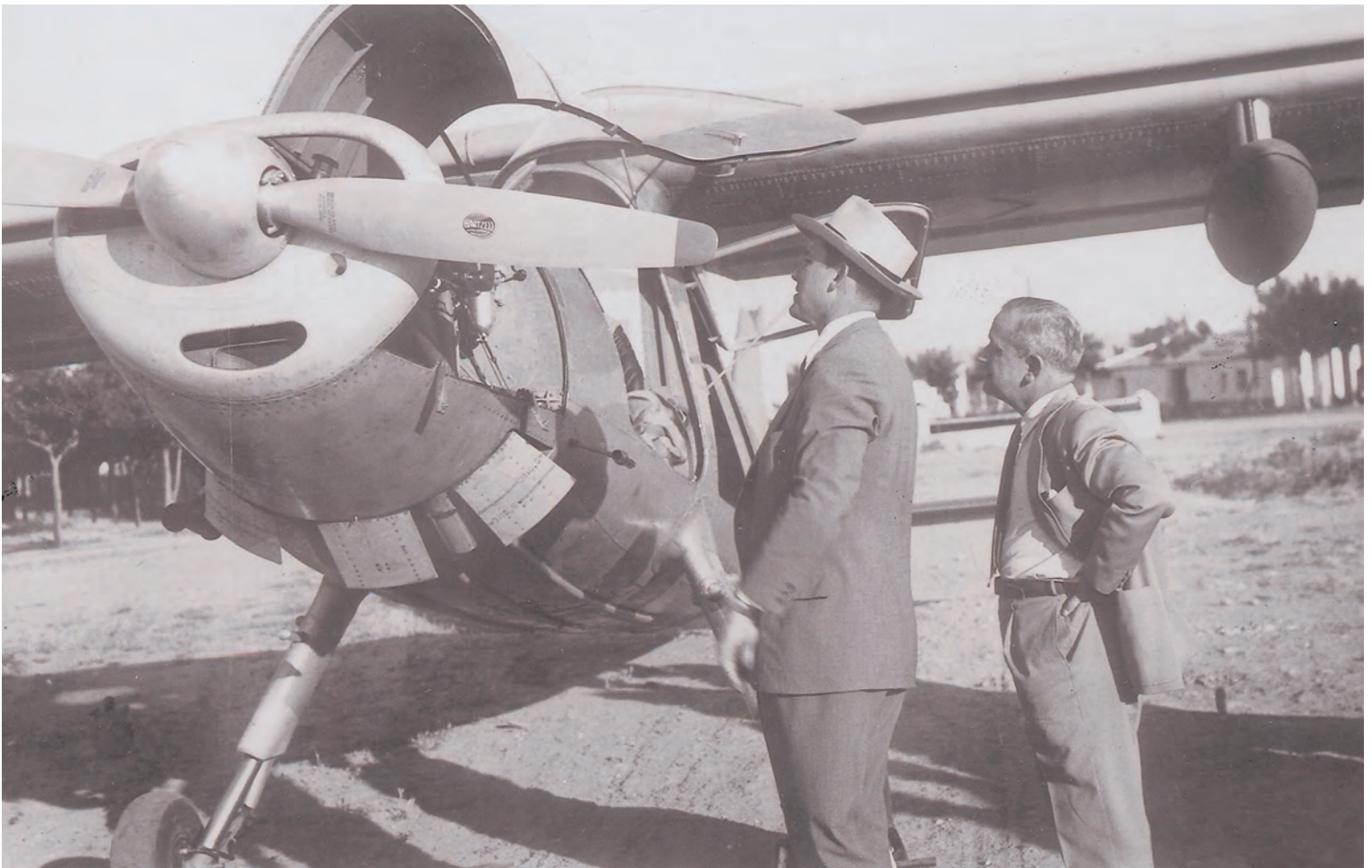
El teniente coronel del Cuerpo de Ingenieros Aeronáuticos Antonio Núñez Rodríguez junto al profesor Claudius Dornier hijo, examinan el motor Continental 0-470-J de 225 HP, del segundo prototipo de la avioneta de enlace Dornier Do 25, matrícula militar XL-9-2, proyectada por la Oficina Técnica Dornier de Madrid y construida por CASA en Sevilla. (SHYCEA).
